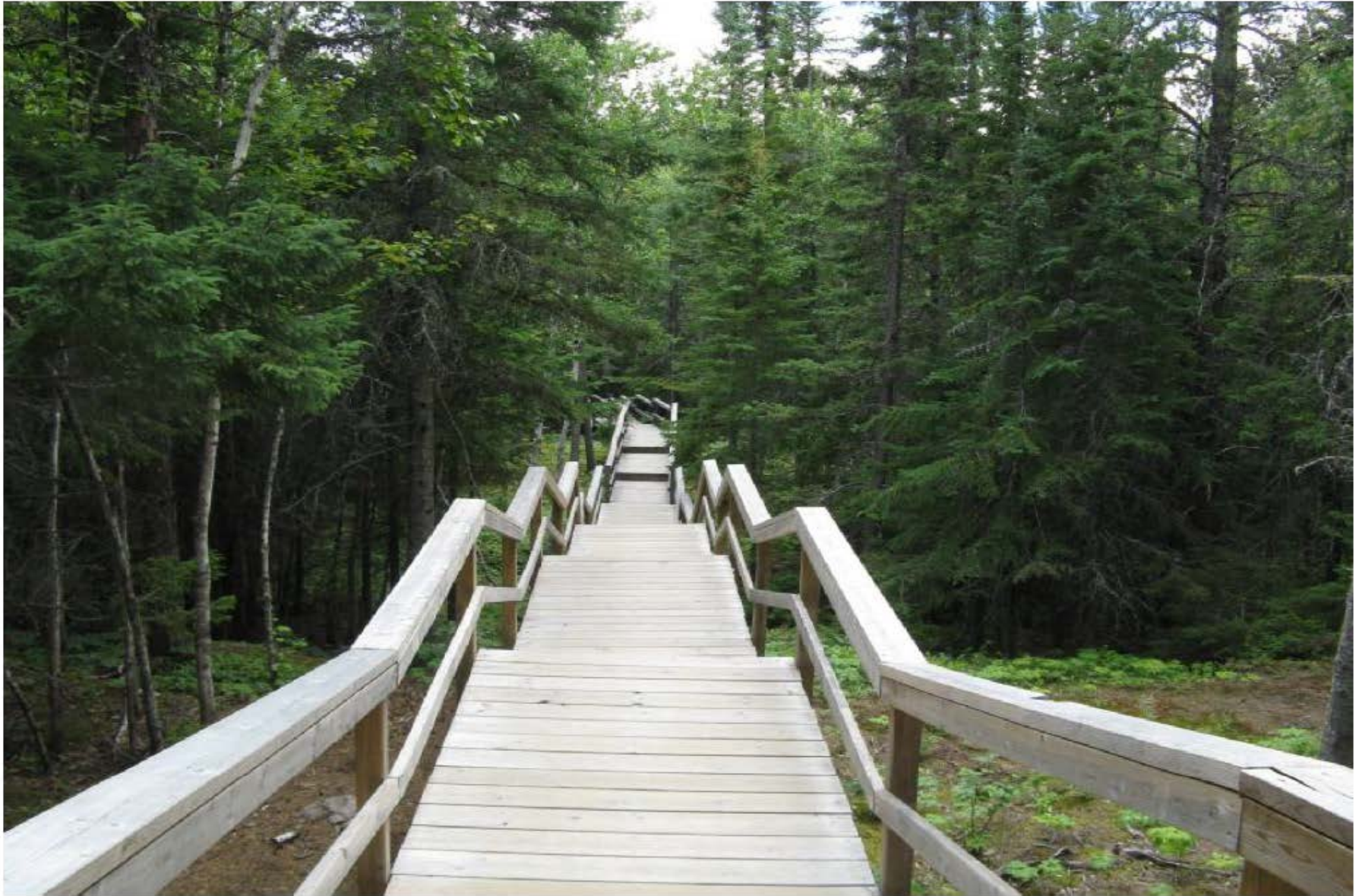
Vue de la passerelle d'accès vers la chute Maligne.
