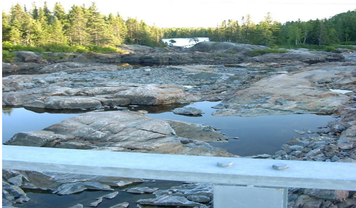
Vue de la rivière Mistassibi en aval de la centrale Minashtuk, centrale au fil de l'eau. >>>>
