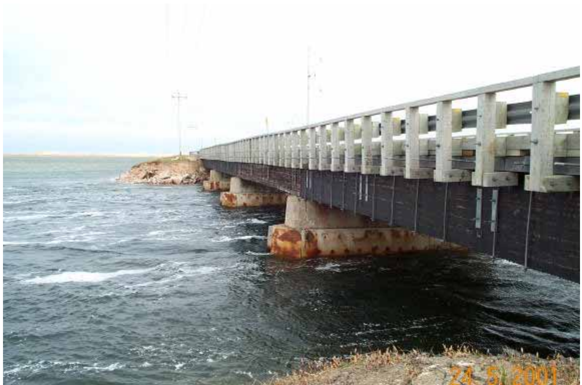
Figure A 9: Position de la station 5, sous le pont du Déroit. Le mouillage se situe entre le premier et le deuxième pilier. Le nord est à l'extrémité éloignée du pont.
