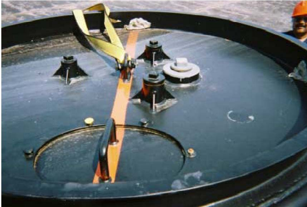
Figure 7-1 : Contenant pour les résines usées
