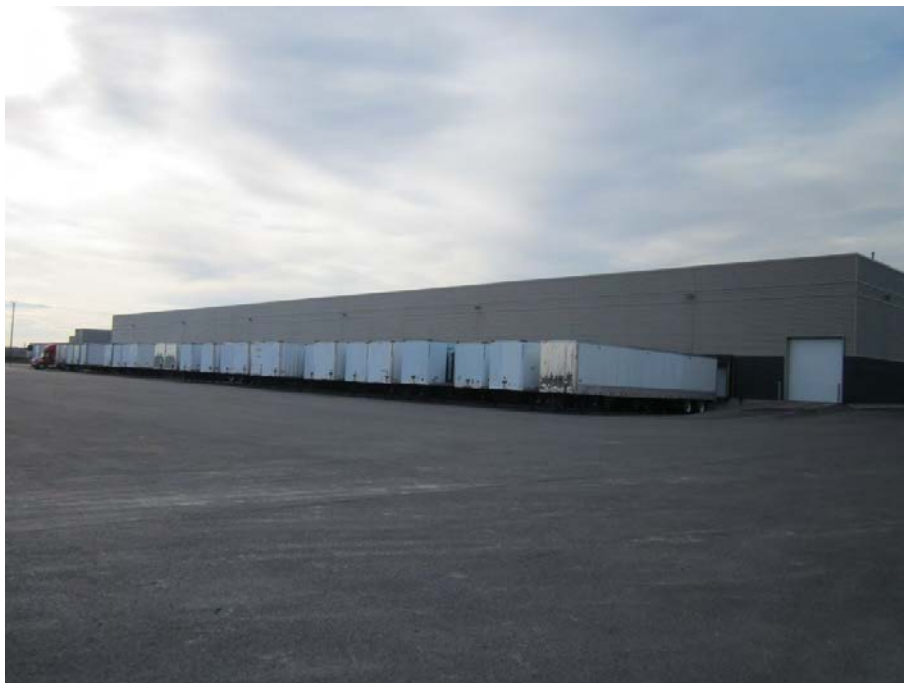
Figure 10 : Propriété voisine située à l'ouest du Site, occupée par un bâtiment commercial à locataires multiples sis au 3600, rue F.X. Tessier (regardant vers le sud-ouest).
