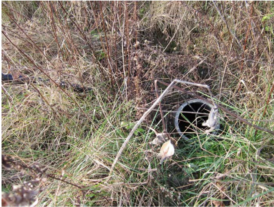
Figure 7 : Forage ouvert observé sur le Site, présumé d'avoir été installé en 2006 par Golder dans le contexte d'une étude géotechnique (BH-6).
