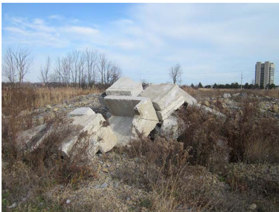
Figure 4 : Débris de béton observés sur le Site (regardant vers le nord-est).
