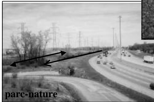
Vue de la passerelle sur l'emprise d'Hydro-Québec, direction est de l'autoroute 40 (avril 2004)
