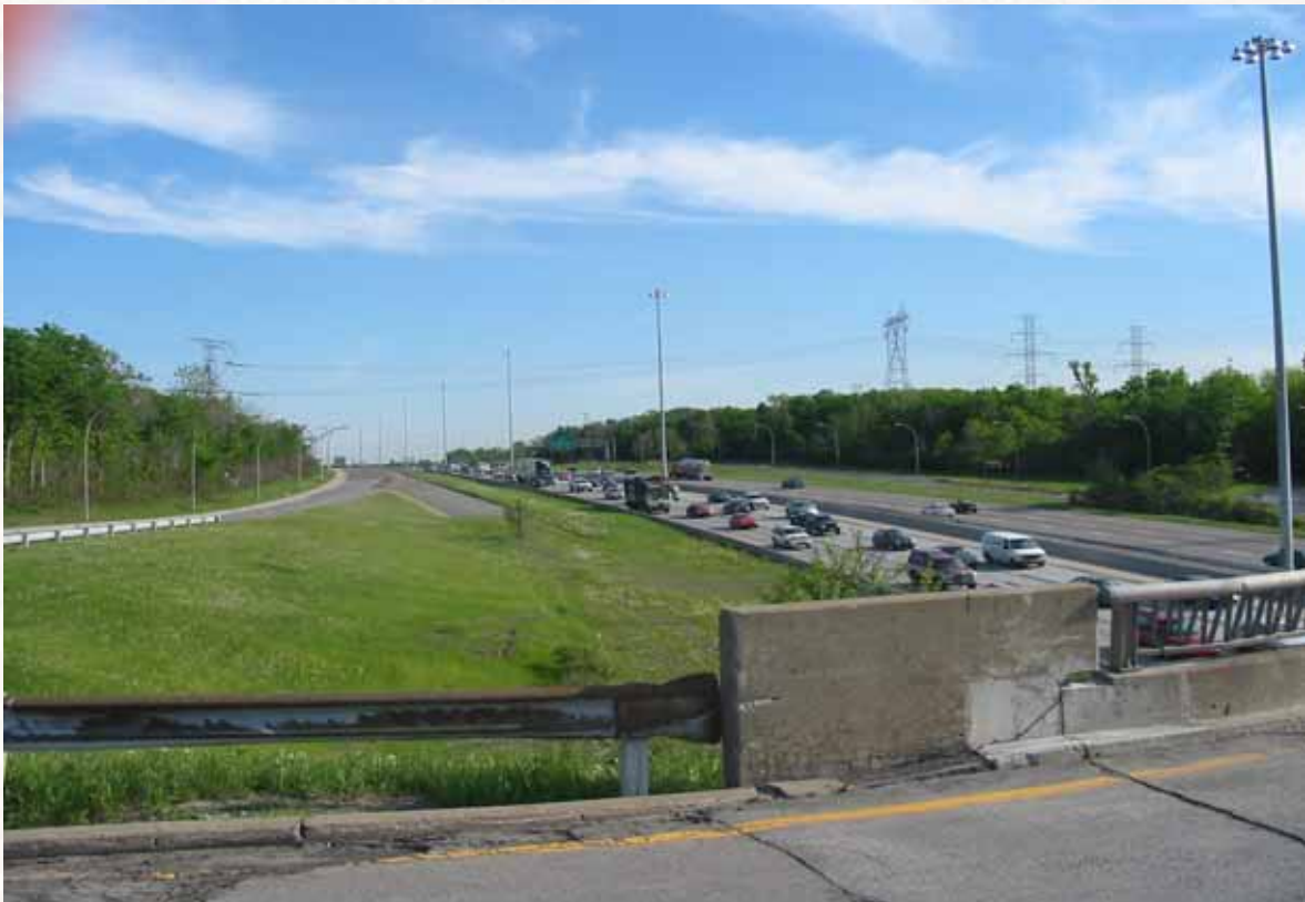
Viaduc train direction Montréal (B)
