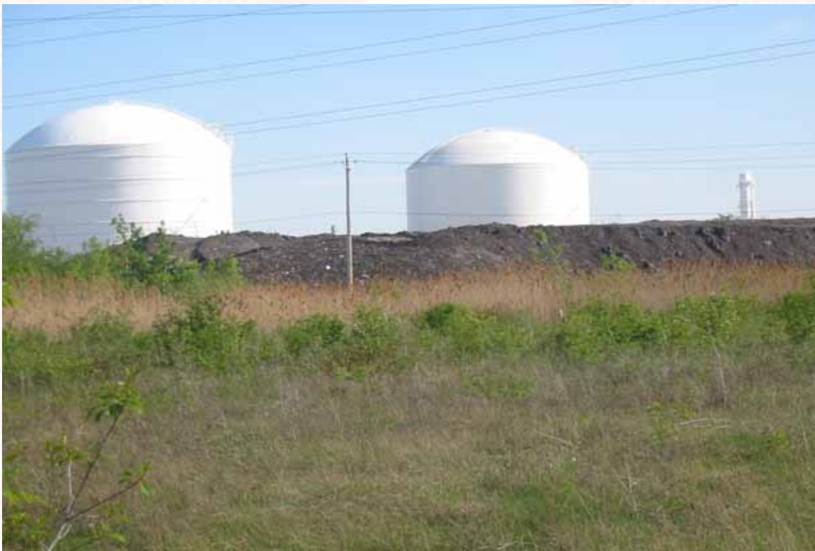
Réservoir Gaz métropolitain (E)
