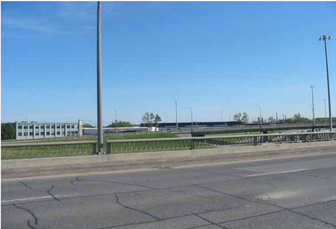
Viaduc direction sud
