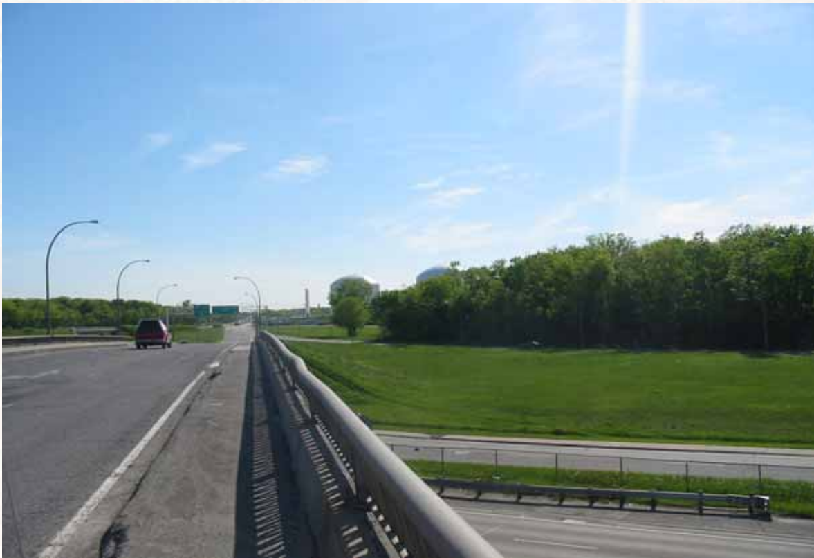
Viaduc direction ouest
