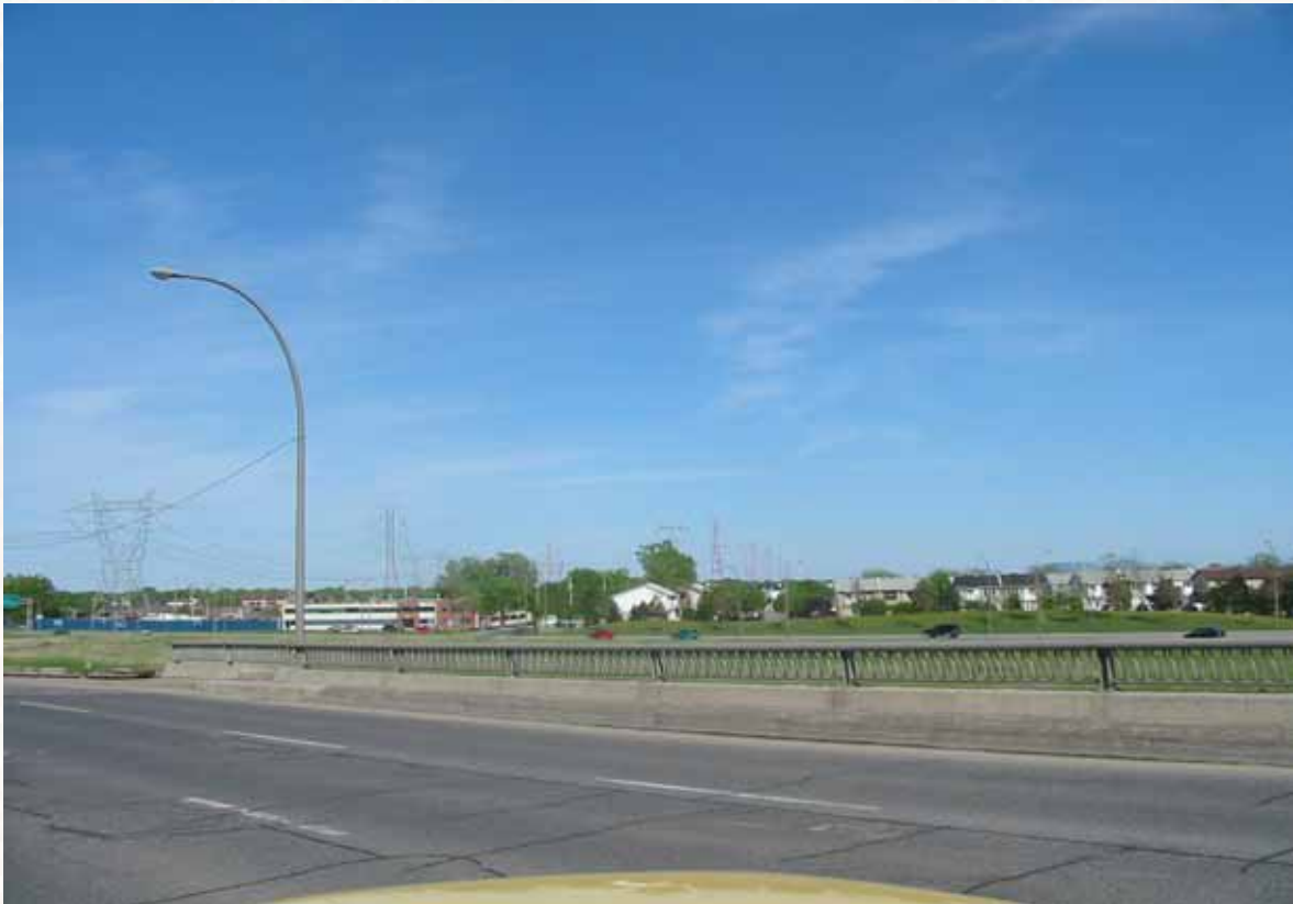
Viaduc direction est)
