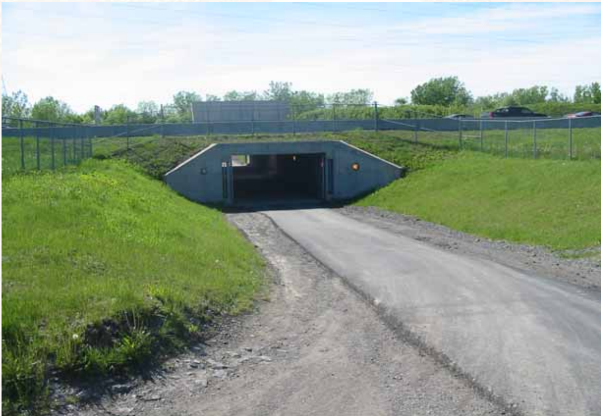
Tunnel sous l'autoroute 40
