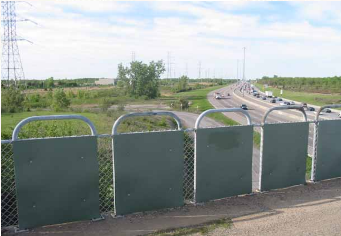
Viaduc train direction Repentigny
