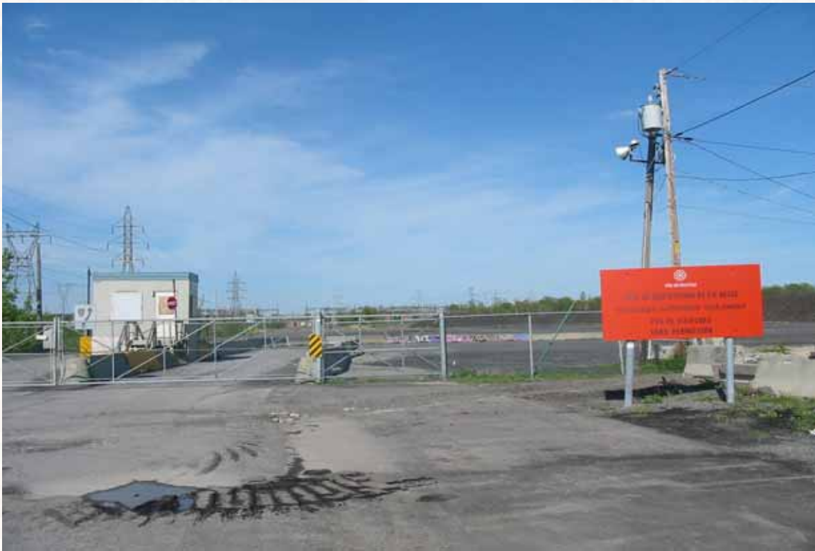
Dépôt de neige
