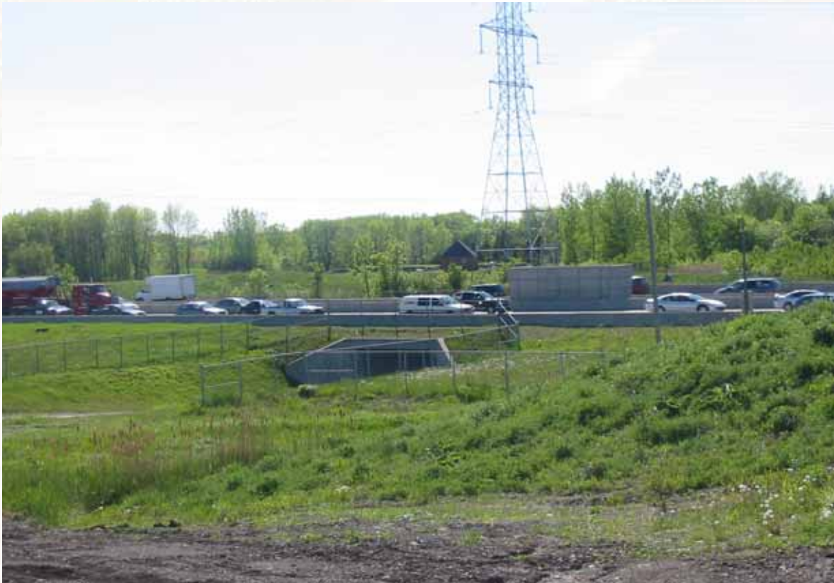
Vanne de sectionnement (vue vers l'ouest)
