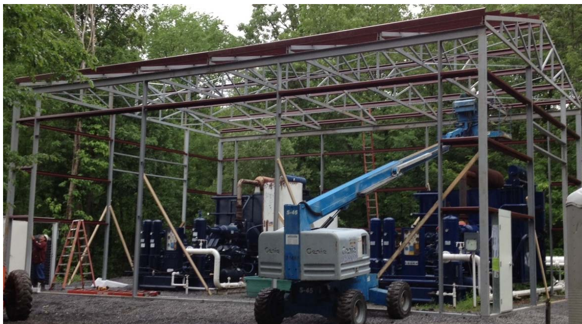
Image 7. Une station de compression des gaz en construction dans le comté de Bradford, Pennsylvanie
