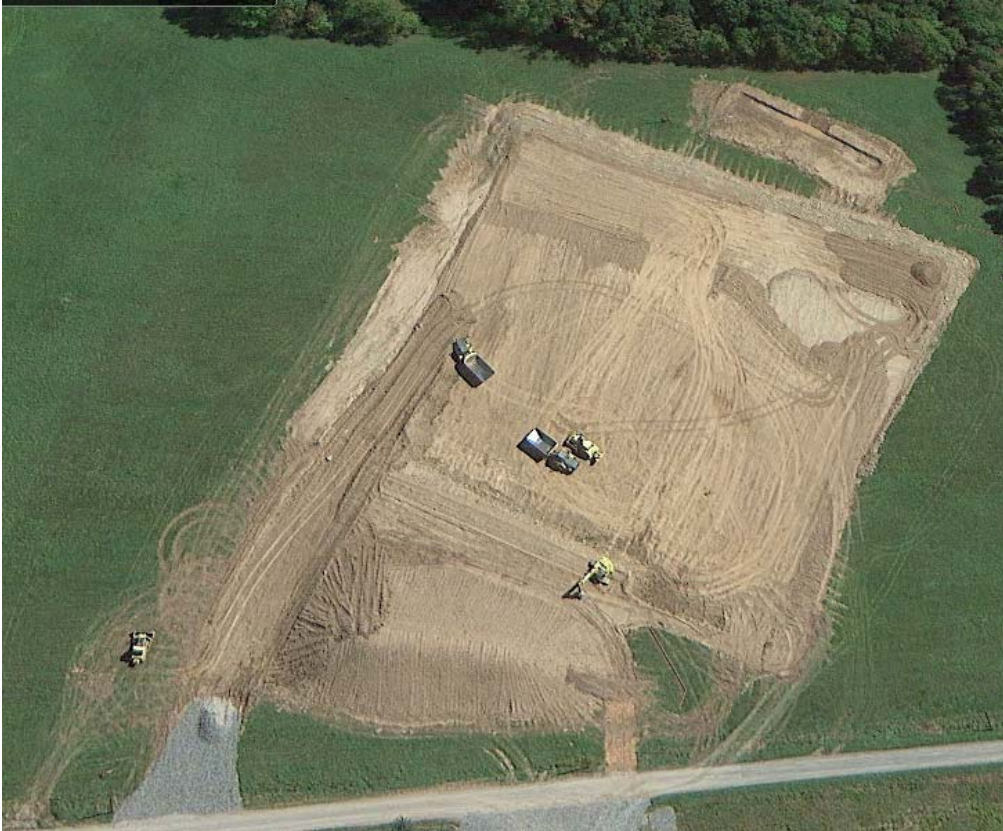
Image 1. Travaux de préparation d'un site par de la machinerie lourde
