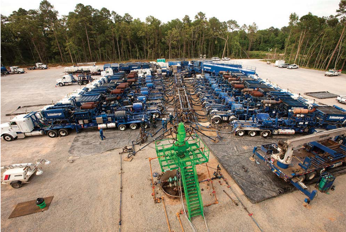
Image 3. Fracturation hydraulique en cours sur un site de forage
