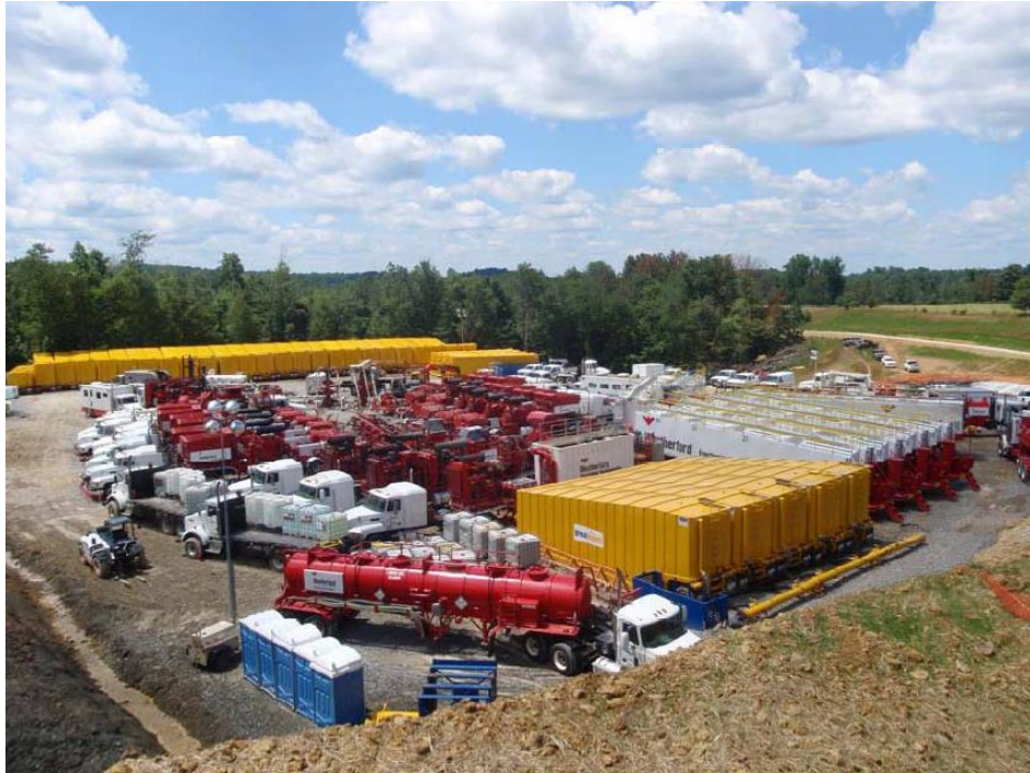
Figure 4 : Préparation à la fracturation (SGEIS 2009)
