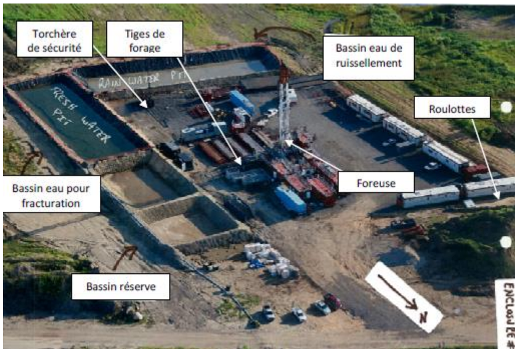
Figure 3 : Disposition du site pour le processus de forage (CIRAIG 2012)
