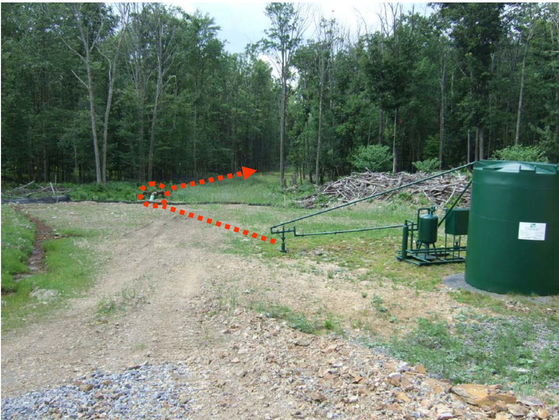
Image 11. Un puits raccordé au réseau de collecte
