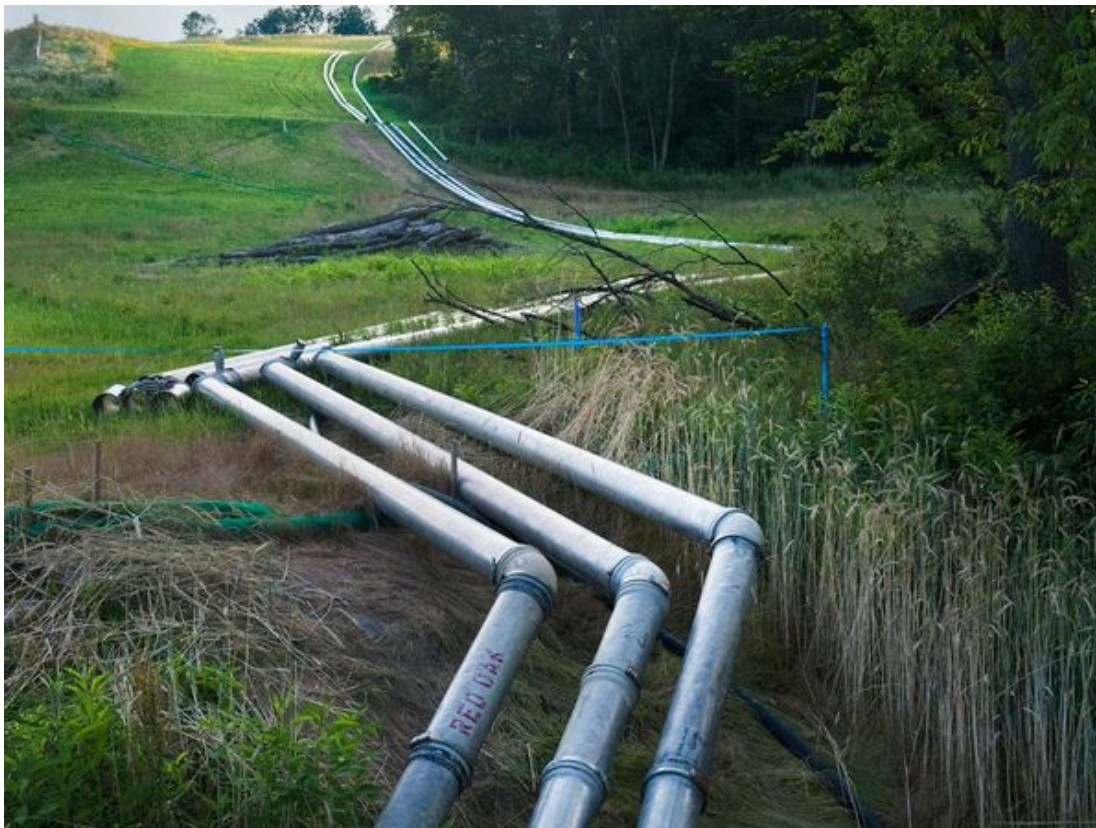
Image 7. Les conduites d'eau permettent de diminuer le nombre de camions en circulation
