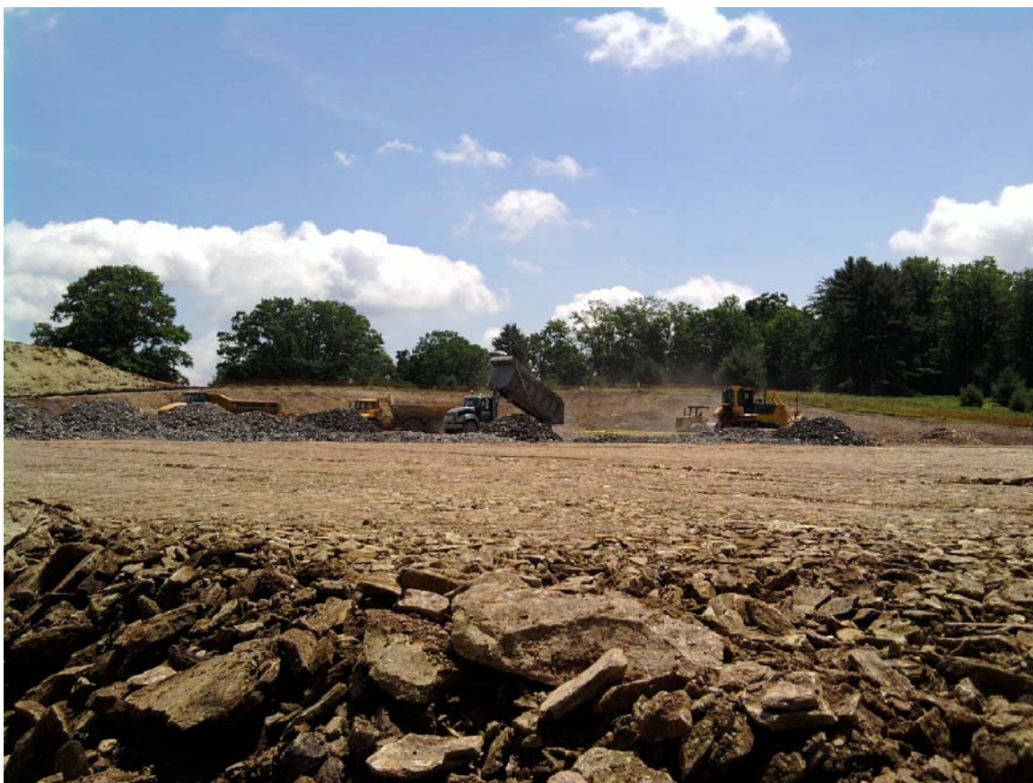
Image 1. Travaux de préparation d'un site de forage
