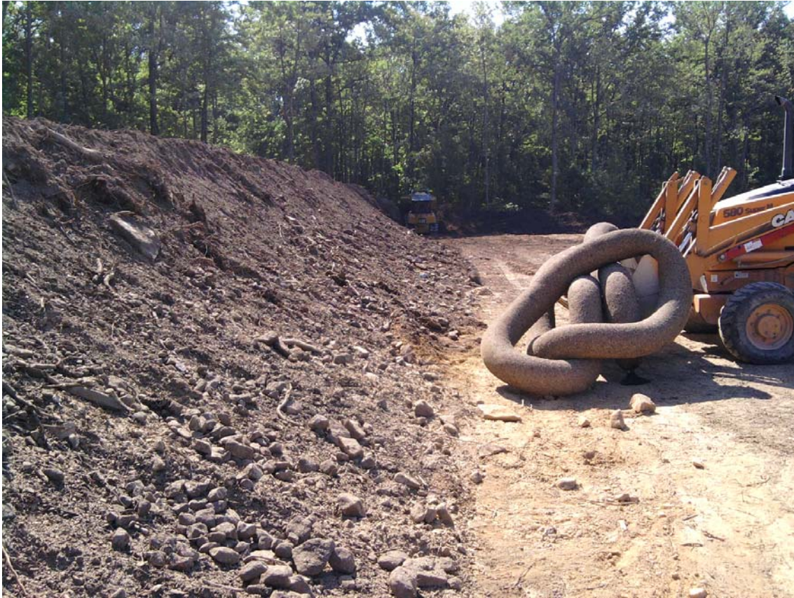
Image 2. Disposition de déblais le long de la surface dégagée
