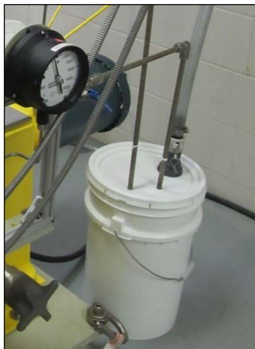
Figure 7 Chambre de dépressurisation
