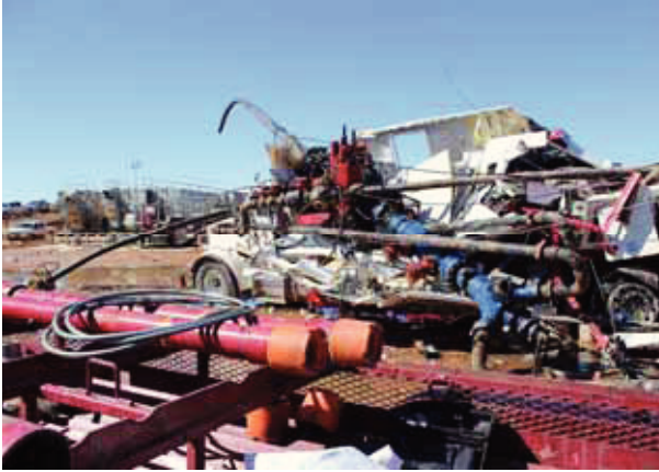
Figure 5-2 Rupture de tubulure lors des opérations de fracturation hydraulique
