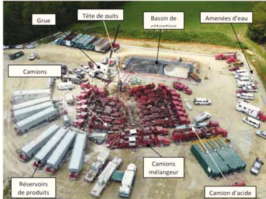
Figure 3-5 Opérations de fracturation typique avec 14 camions pompe (Source : Pennsylvanie Indépendant Oil & Gas Association, Internet)
