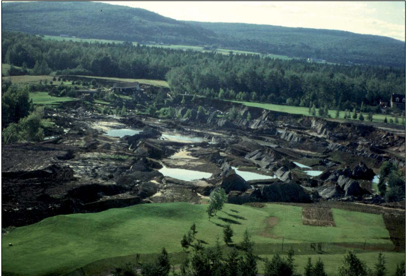
Figure 8 Étalement latéral (survenu à Saint-Liguori en 1989)
