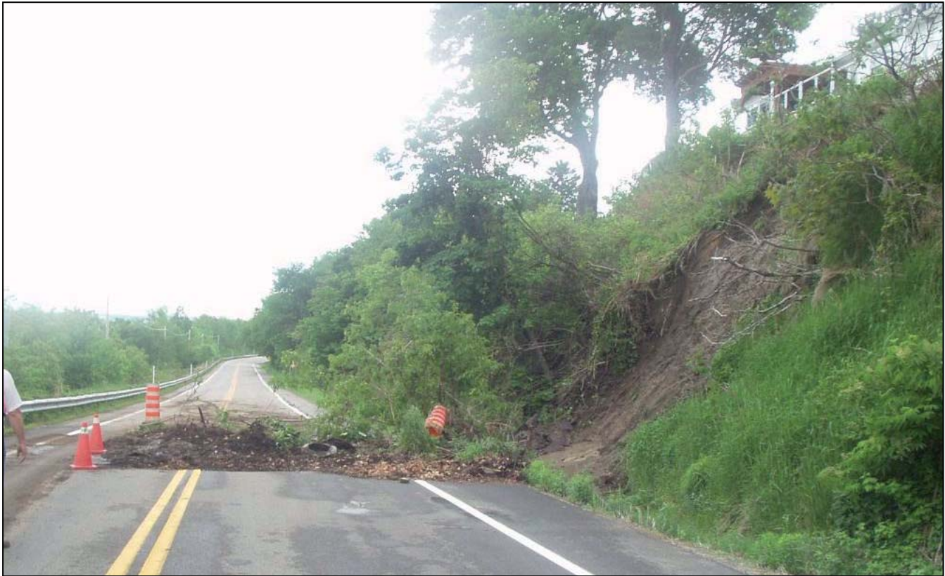
Figure 2 Glissement superficiel (survenu à Grondines en 2006)
