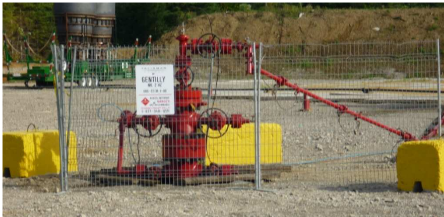
Figure 15 : Tête de puits standard.
