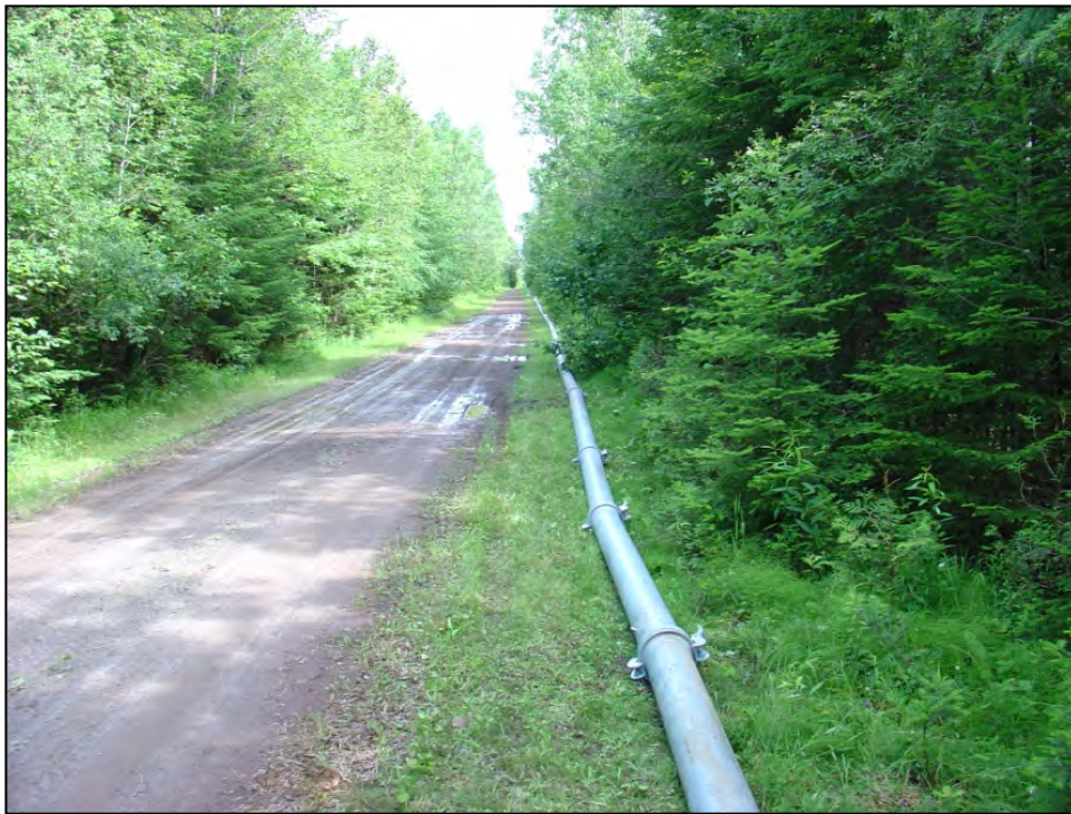
CONDUITE D'EAU INSTALLÉE EN BORDURE D'UN CHEMIN FORESTIER À SAINT-ÉDOUARD-DE-LOTBINIÈRE, DANS LE CADRE DES TRAVAUX DE FRACTURATION HYDRAULIQUE. (ÉTÉ 2009)
