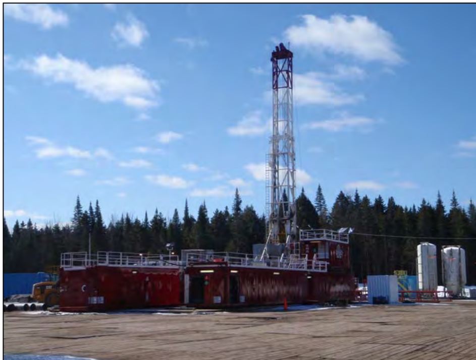
SITE À SAINT-ÉDOUARD-DE-LOTBINIÈRE AMÉNAGÉ AVEC DES MATELAS DE CHÊNE. (2008)
