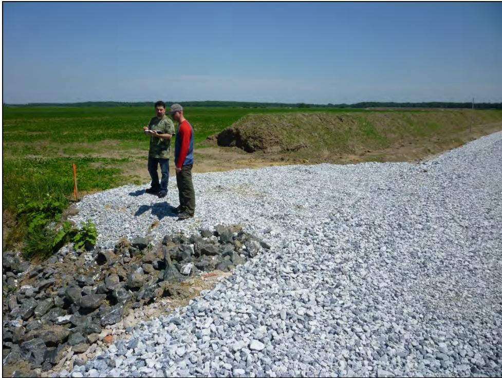
ENROCHEMENT DU FOSSÉ DE DRAINAGE DU CHEMIN D'ACCÈS MENANT AU SITE À SAINTE-GERTRUDE. (2010)
