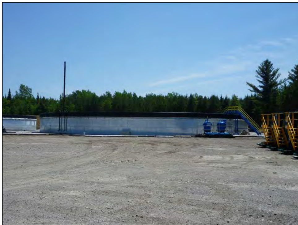
BASSIN C-RING AMÉNAGÉ SUR LE SITE GENTILLY N° 2. (2010)
