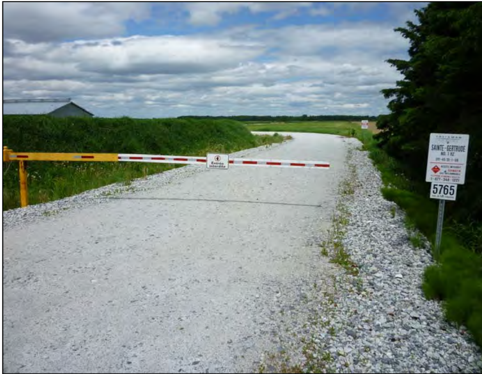
CHEMIN D'ACCÈS DU SITE SAINTE-GERTRUDE N° 1 AMÉNAGÉ AVEC DES RÉSIDUS DE BÉTON CONCASSÉ. (2010)
