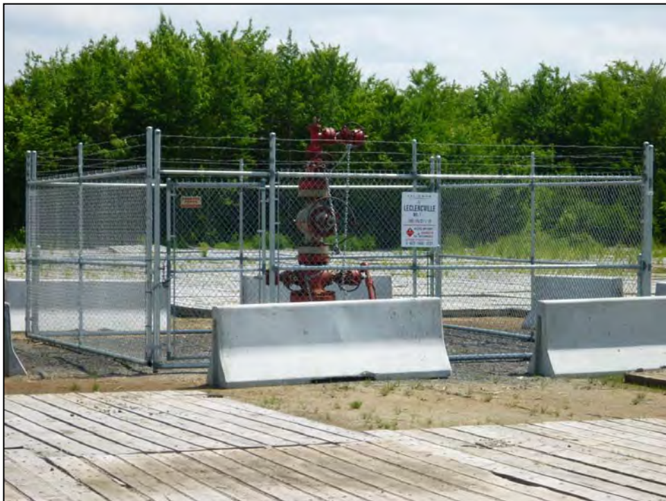
PÉRIMÈTRE CLÔTURÉ AUTOUR DU PUIS LECLERCVILLE N° 1. (2012)
