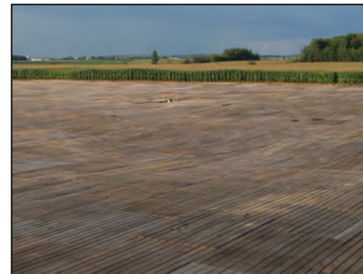
Matelas de chêne utilisés durant la construction
