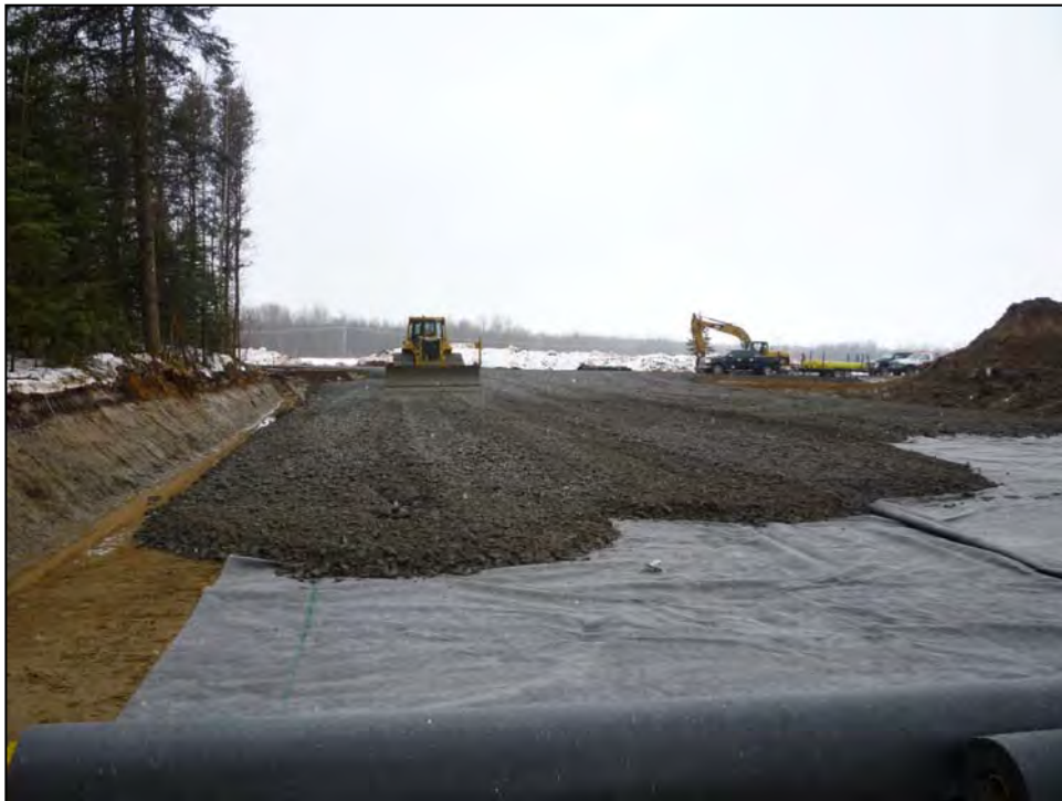
AMÉNAGEMENT DU SITE D'EXPLORATION GAZIÈRE À FORTIERVILLE. (2010)
