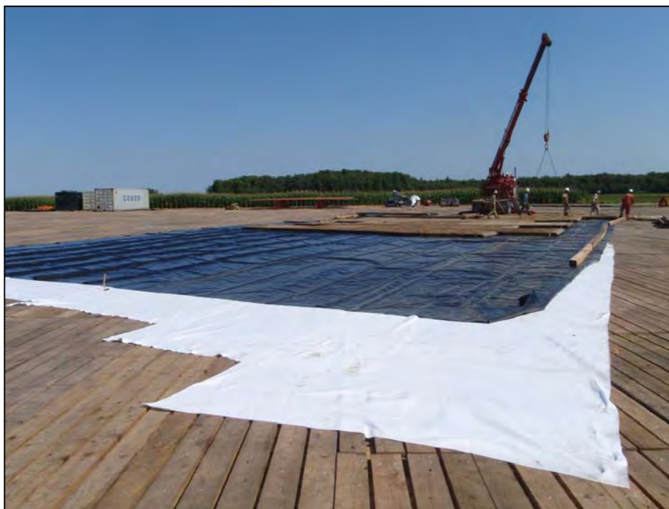
INSTALLATION D'UNE MEMBRANE IMPERMÉABLE SUR LA MEMBRANE GÉOTEXTILE (BLANCHE) À L'EMPLACEMENT PRÉVU POUR LA FOREUSE SUR LE SITE D'EXPLORATION GAZIÈRE À LA VISITATION-DE- YAMASKA. (2008)
