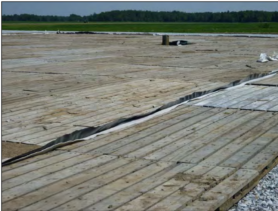
MESURE DE CONFINEMENT SECONDAIRE COMPLÉTÉE SUR LE SITE D'EXPLORATION GAZIÈRE À SAINTE-GERTRUDE SUR L'EMPLACEMENT PRÉVU POUR LA FOREUSE. (2010)
