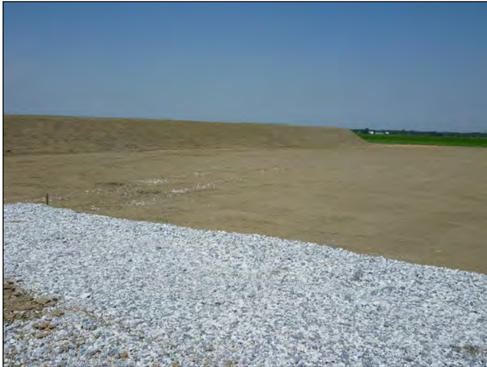
ANDAIN DE SOL ARABLE FORMANT UN ÉCRAN ACOUSTIQUE SUR LE SITE À SAINTE-GERTRUDE. (2010)
