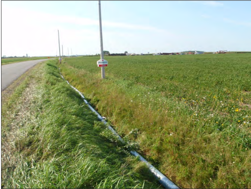
CONDUITE D'EAU INSTALLÉE DANS LE FOSSÉ LONGEANT LE RANG SAINT-PIERRE À LA VISITATION-DE-YAMASKA, DANS LE CADRE DES TRAVAUX DE FRACTURATION. (AUTOMNE 2008)
