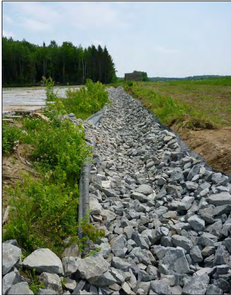
ENROCHEMENT DU FOSSÉ DE DRAINAGE DU SITE À FORTIERVILLE. (2010)
