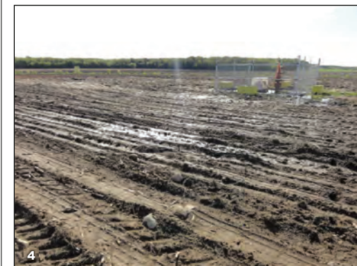
4 Vue sur le puits et l'aire déboisée : problématiques de drainage.
