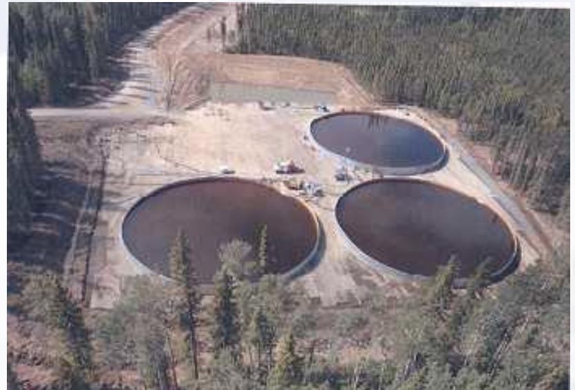
Bassins de récupération hors sol. Source : Canadian Institute Eastern Canada Shale gas symposium, Montréal, mars 2011.
