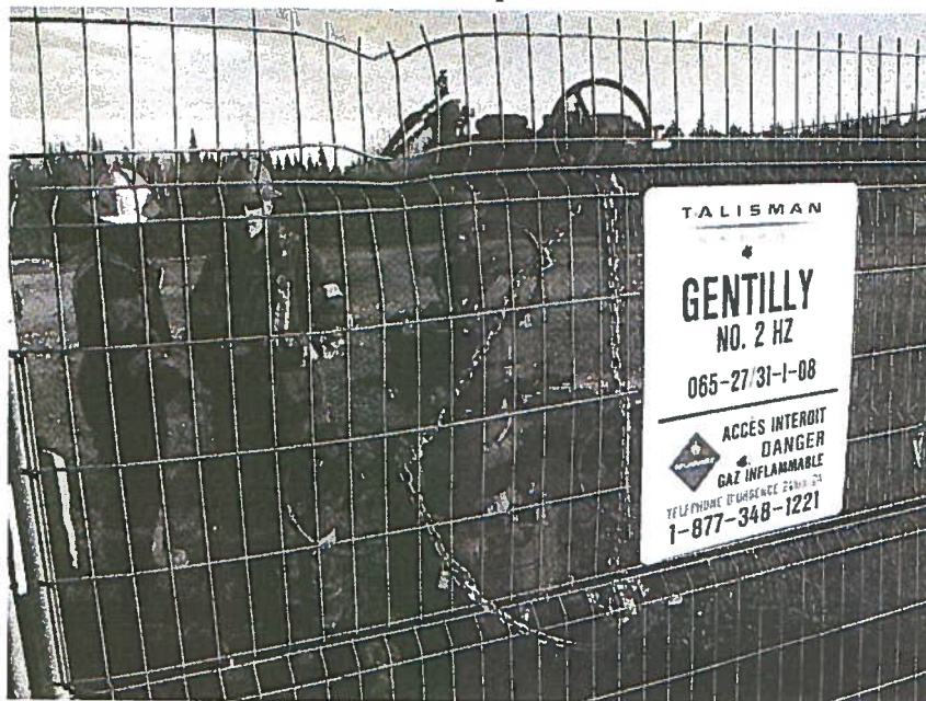
Tête de puits, échantillonnage près du conducteur
