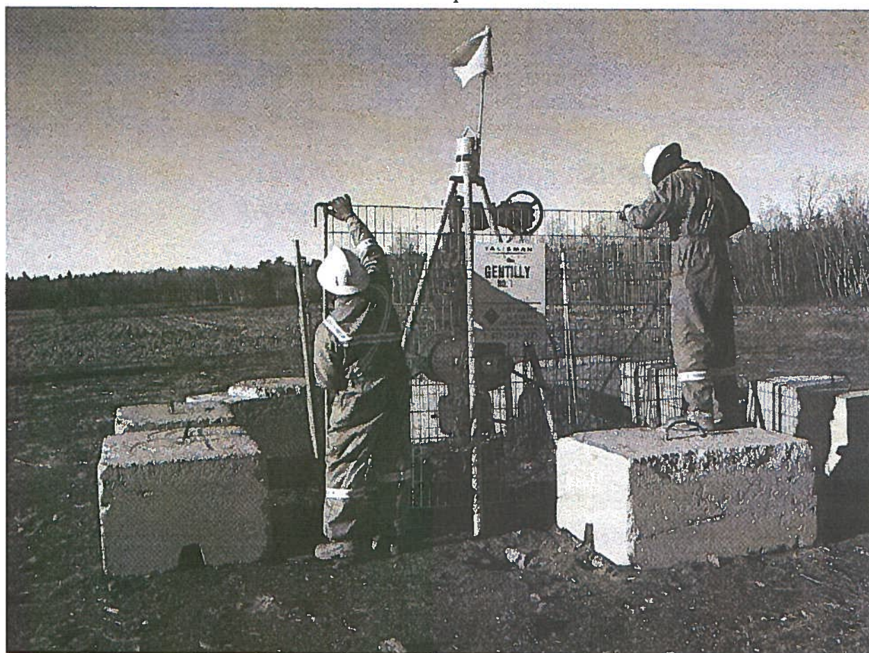
Tête de puits, mesure des émissions de l'évent du coffrage de surface
