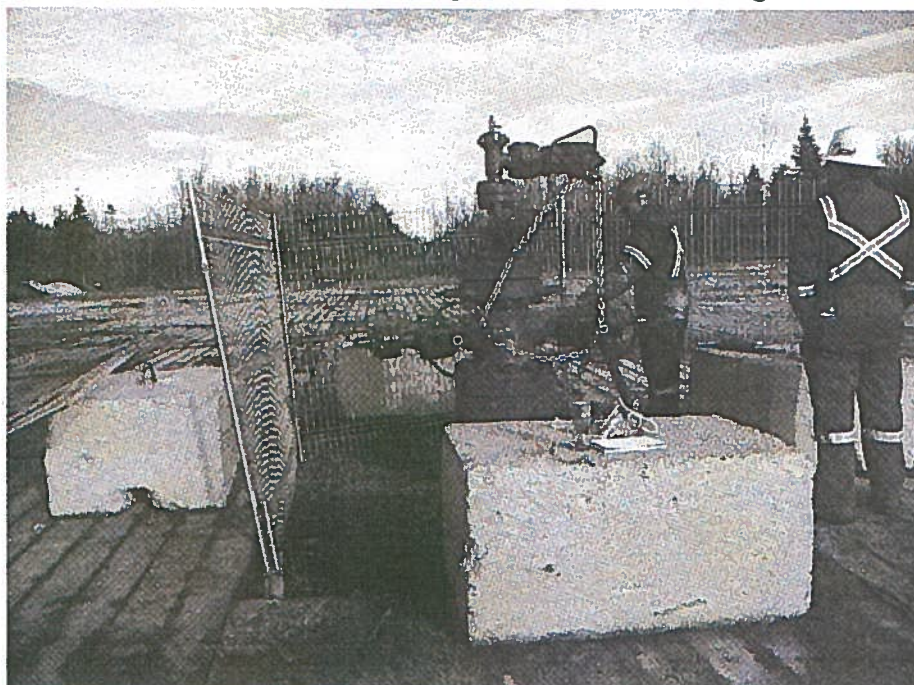
Échantillonnage des émissions de gaz de l'évent du coffrage de surface
