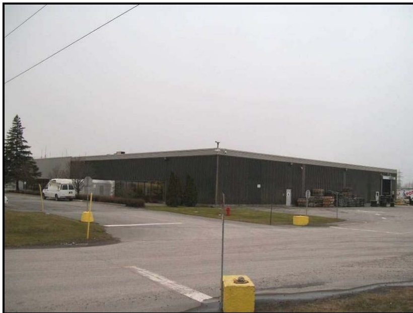
Photo n° 59 (2009-12-049) : Bâtiment du magasin provincial.
