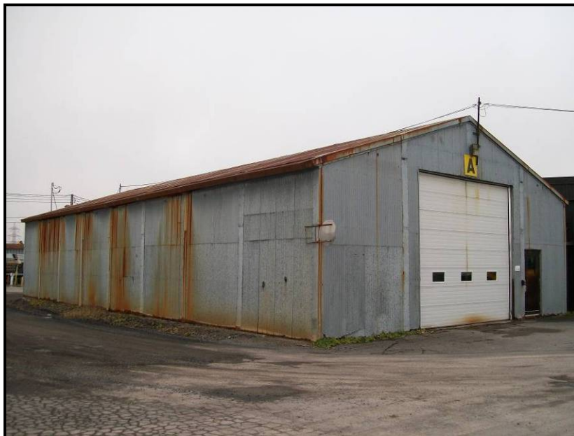
Photo n° 7 (2009-12-04) : Vue du bâtiment A.
