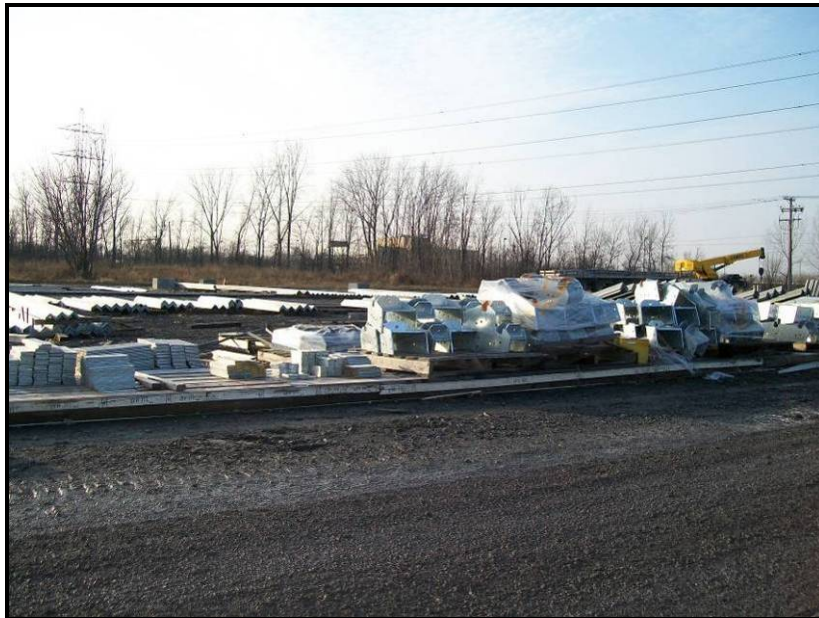
Photo n° 76 (2009-12-03) : Entreposage d'acier galvanisé dans l'aire remblayée du secteur ouest.
