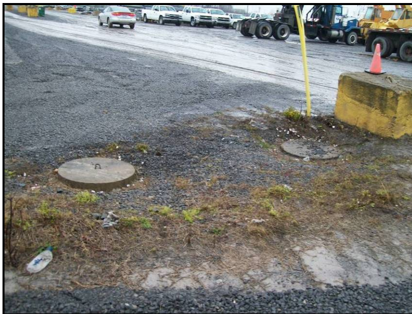
Photo n° 123 (2009-12-03) : Regards en béton des installations septiques du bâtiment P.
