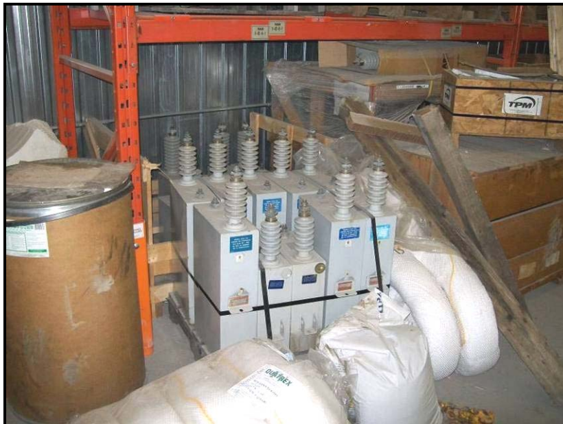
Photo n° 46 (2009-12-01) : Entreposage de condensateurs neufs dans le bâtiment V.
