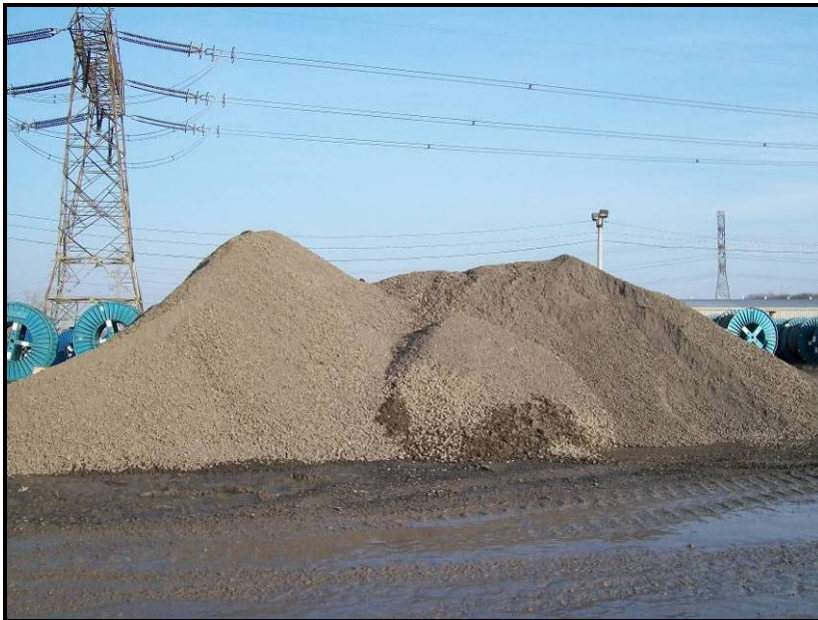
Photo n° 95 (2009-12-02) : Entreposage de pierre concassée dans la zone d'entreposage n° 30.
