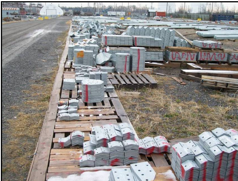
Photo n° 74 (2009-12-02) : Entreposage de raccords et de plaques de renforcement en acier galvanisé dans la zone d'entreposage n° 45.
