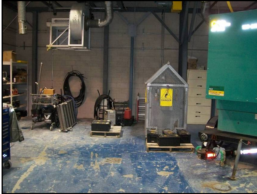
Photo n° 55 (2009-12-01) : Atelier d'entretien mécanique dans le bâtiment des génératrices. Des batteries et des outils sont entreposés sur une étagère à gauche sur la photo.
