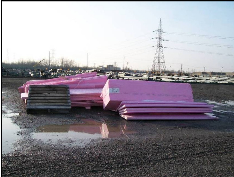
Photo n° 91 (2009-12-02) : Entreposage de panneaux de polystyrène dans la zone d'entreposage n° 33.
