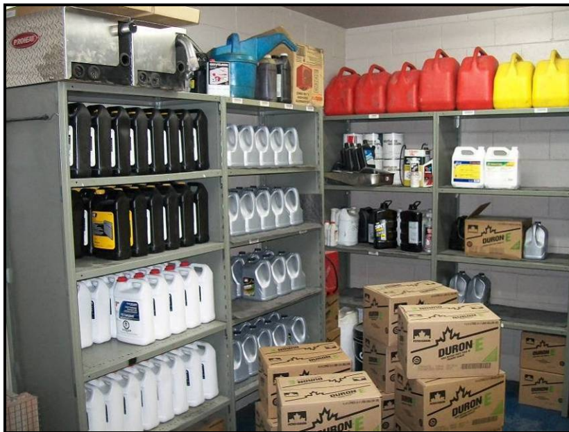
Photo n° 56 (2009-12-01) : Entreposage de bidons d'huile dans une pièce du bâtiment des génératrices.
