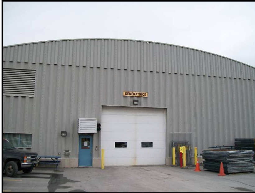
Photo n° 50 (2009-12-01) : Bâtiment des génératrices.
