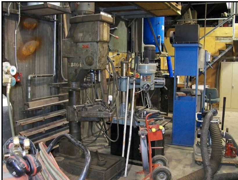
Photo n° 28 (2009-12-01) : Appareils électriques utilisés dans le bâtiment M.
