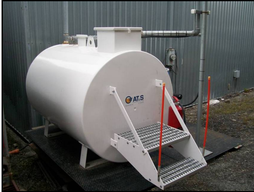
Photo n° 104 (2009-12-04) : Réservoir d'huiles usées (F) entre les bâtiments B et D.
