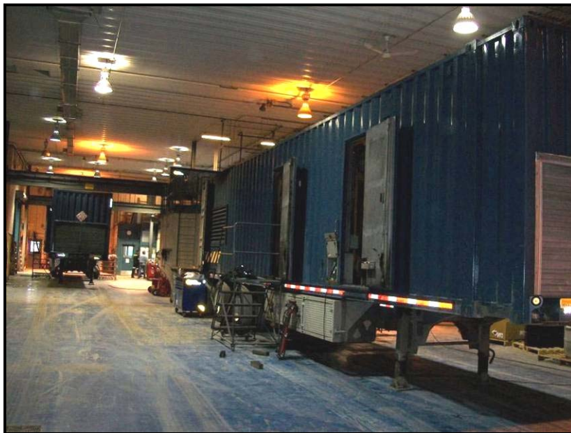
Photo n° 53 (2009-12-01) : Génératrices sur semi-remorques stationnées pour entretien dans le bâtiment des génératrices.
