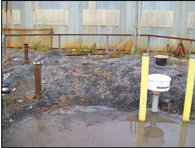
Photo n° 102 (2009-12-01) : Emplacement des réservoirs souterrains (A et B) du poste de distribution d'essence et de diesel.
