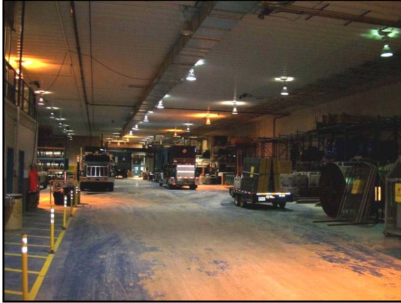
Photo n° 51 (2009-12-01) : Aire centrale du bâtiment des génératrices.
