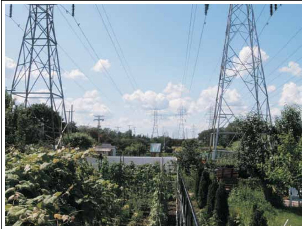
A. Situation avant 1995 : trois lignes à 120 kV présentes dans l'emprise
