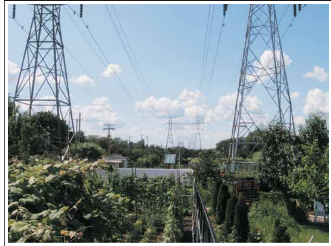
B. Situation actuelle : deux lignes à 120 kV présentes dans l'emprise
