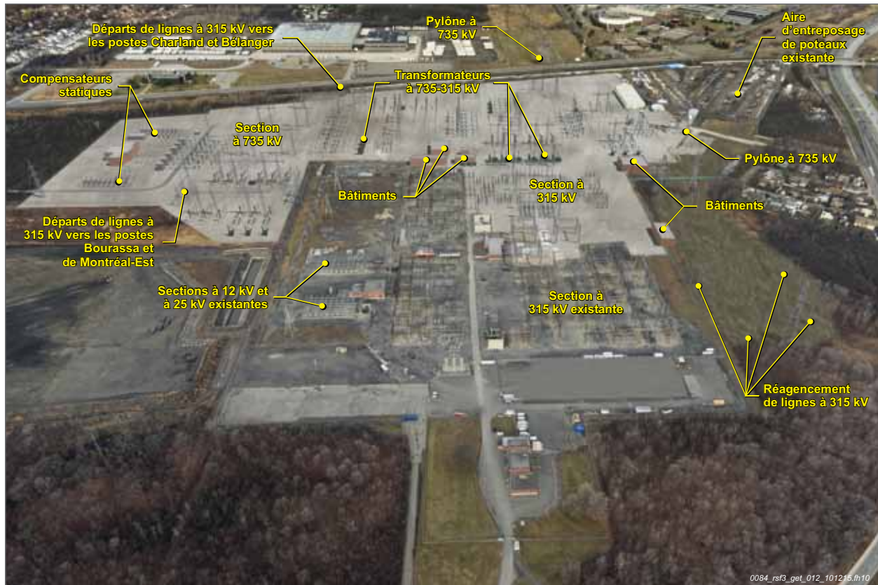
Figure 3 : Simulation visuelle du poste du Bout-de-l'Île à l'étape finale d'ajout d'équipements à 735 kV
