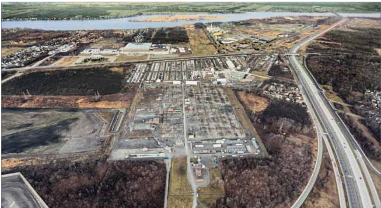
Photo 1 : Poste du Bout-de-l'Île existant
