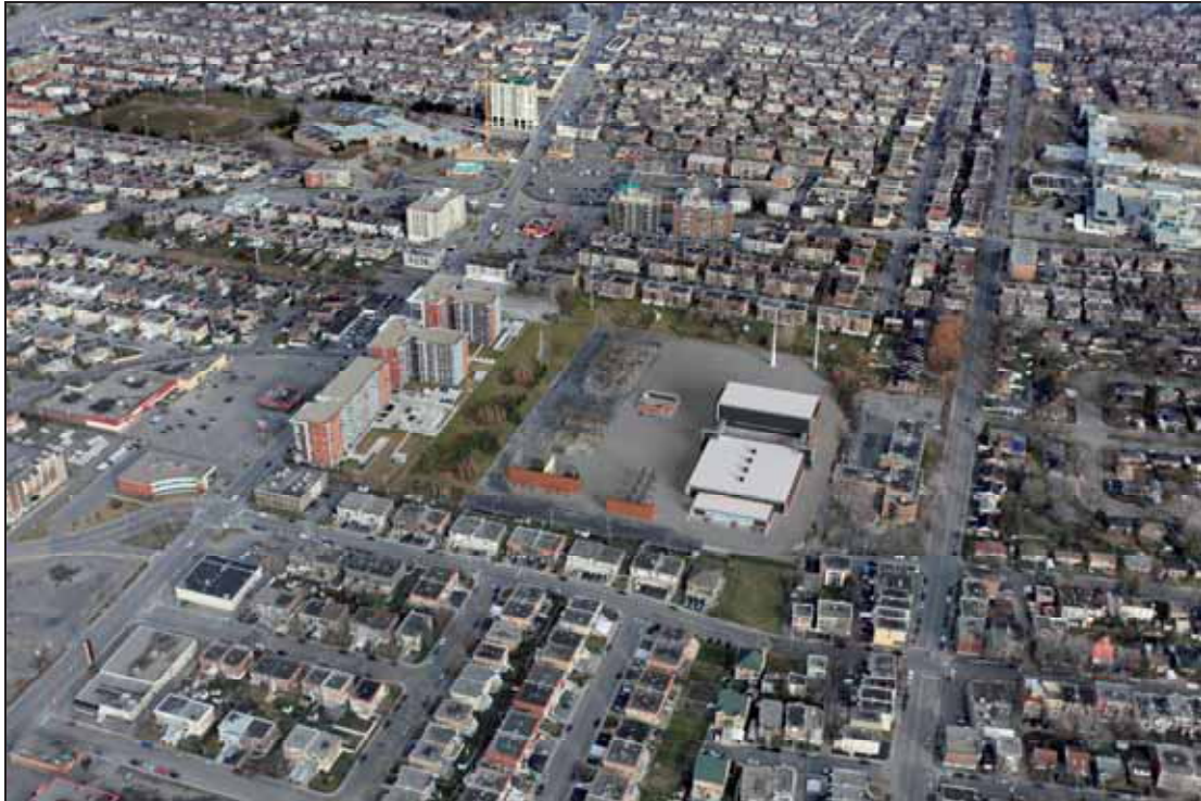
Figure 2-7 : Simulation visuelle de l'option 3 (nouveau poste compact à l'emplacement du poste existant)
