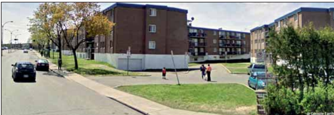
Photo 4-11 : Immeubles d'appartements du boulevard Viau
