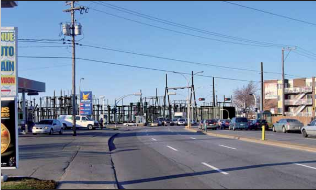
Figure 5-2 : Simulation visuelle du poste projeté à l'emplacement Viau (option 2) – Vue depuis le boulevard Viau
