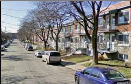
A. Duplex sur la 27 e Avenue
