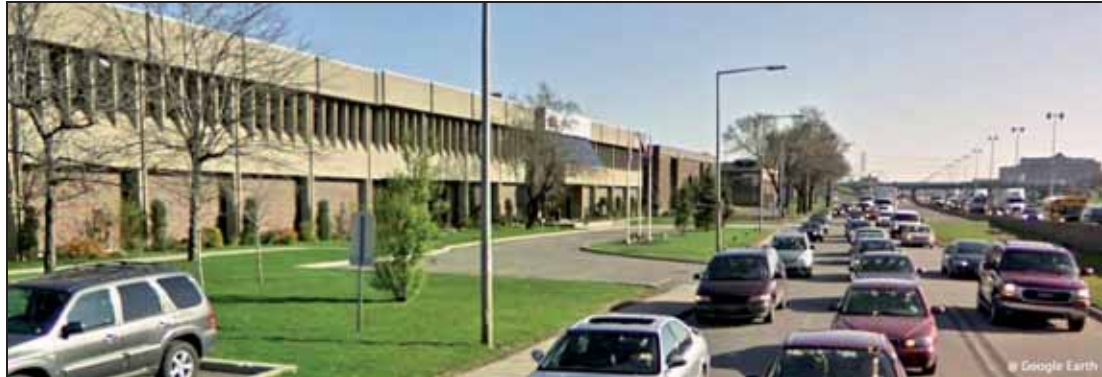
Photo 4-22 : Bâti industriel le long de l'autoroute 40
