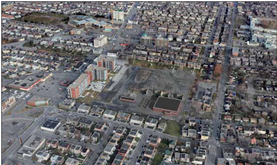
Figure 2-5 : Simulation visuelle de l'option 1 (nouveau poste classique à l'emplacement du poste existant)
