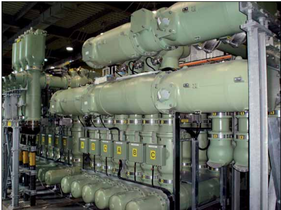
Photo 2-1 : Exemple d'appareillage isolé au gaz SF 6
