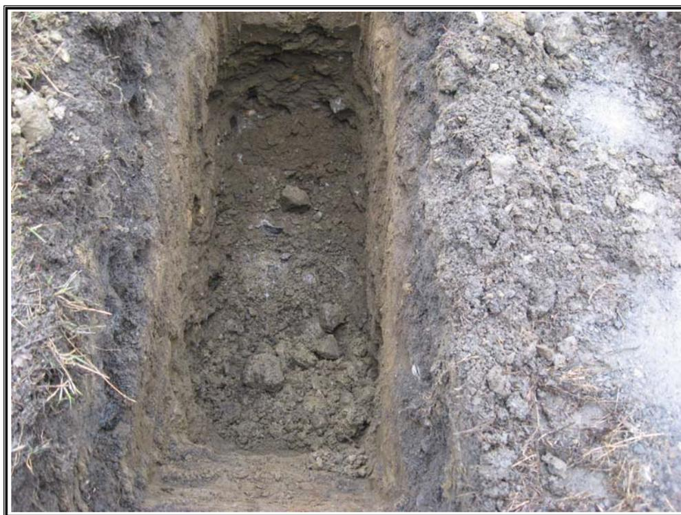
**PHOTO 7 :** Intérieur du puits d'exploration PU-29 où des sols dans la plage « A-B » ont été observés.
