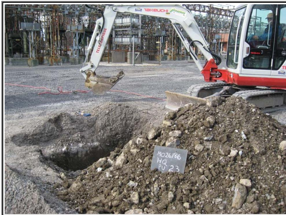
**PHOTO 5** : Secteur du puits d'exploration PU-23 où des structures de béton désaffectées ont été observées.
