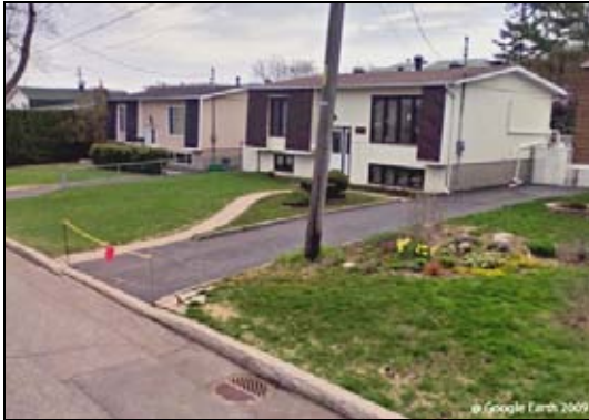
A. Maisons de plain-pied (bungalows) sur la 43 e Avenue
