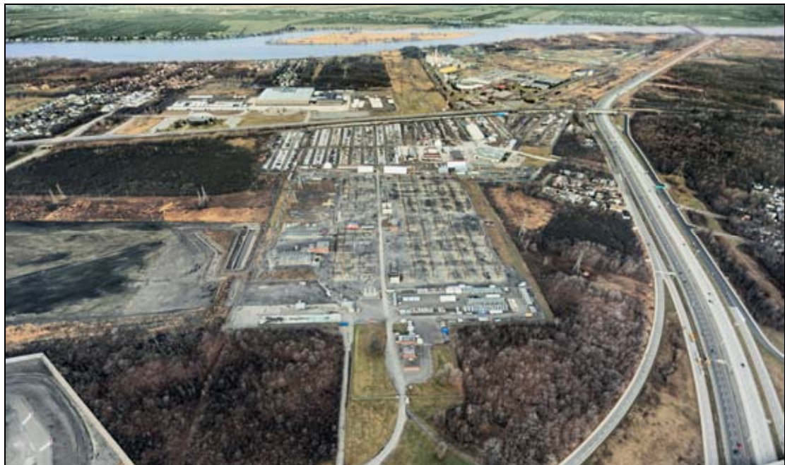
Photo 2-1 : Poste du Bout-de-l'Île existant
