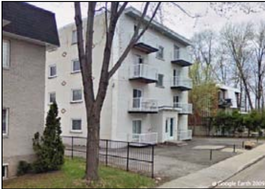
C. Immeuble d'appartements sur la 40 e Avenue
