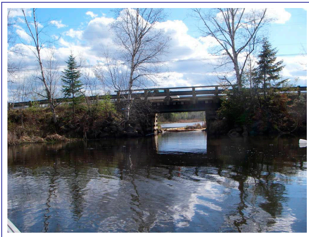
PHOTO 1 — Section amont de la baie Charette, délimitée par le pont sur le chemin Charette
