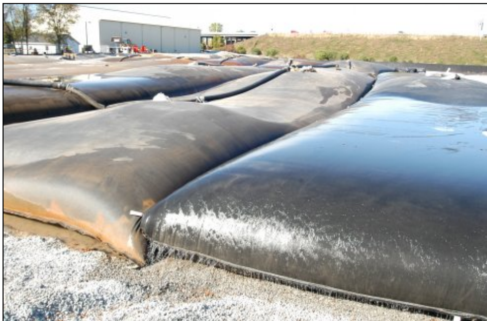
Photo 2.3 Géotubes en phase remplissage
