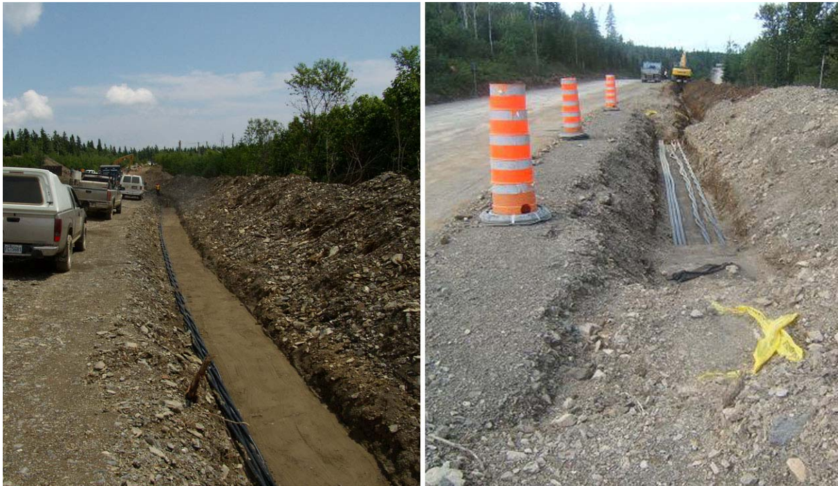
Figure 3.6 Installation du réseau collecteur souterrain
