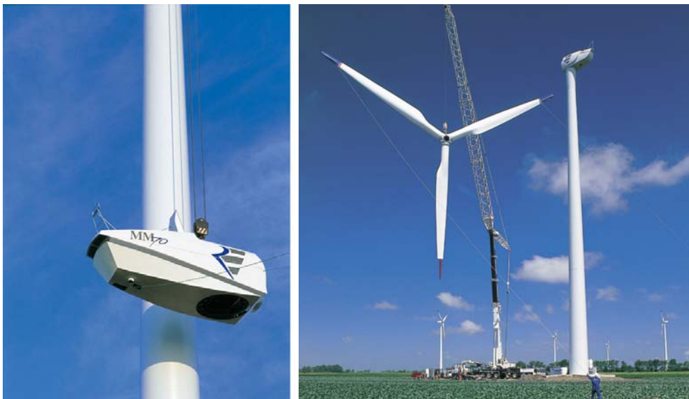
Figure 3.5 Assemblage d'une éolienne
