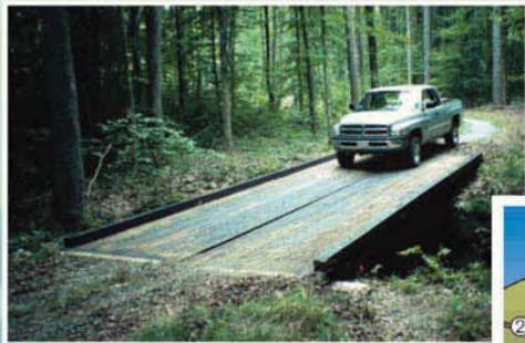
Pontage temporaire pour la traversée d'un cours d'eau par la machinerie
