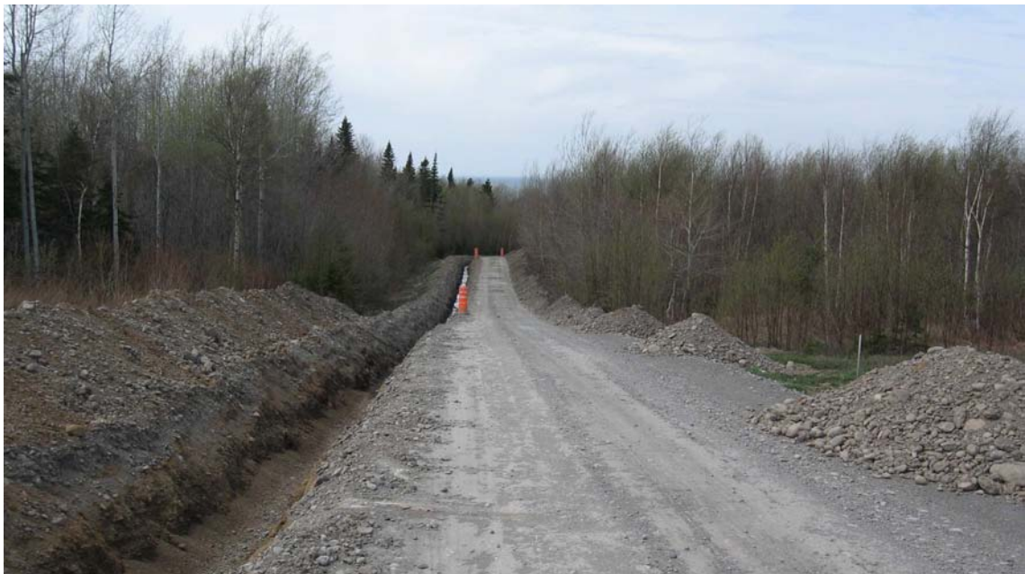
Figure 3.14 Tranchée requise pour l'enfouissement du réseau collecteur
