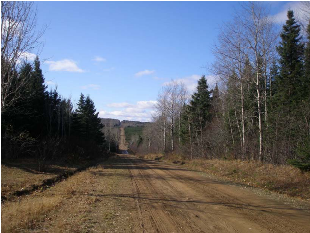
Figure 3.9 Chemin d'accès d'un parc éolien
