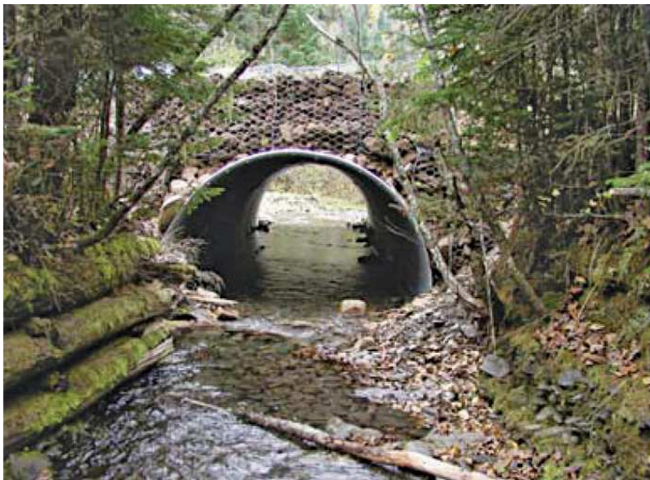
Figure 3.11 Exemple de ponceau en arche
