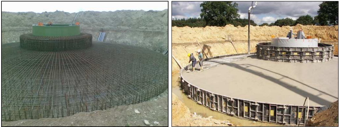
Figure 3.6 Fondation type d'une éolienne
