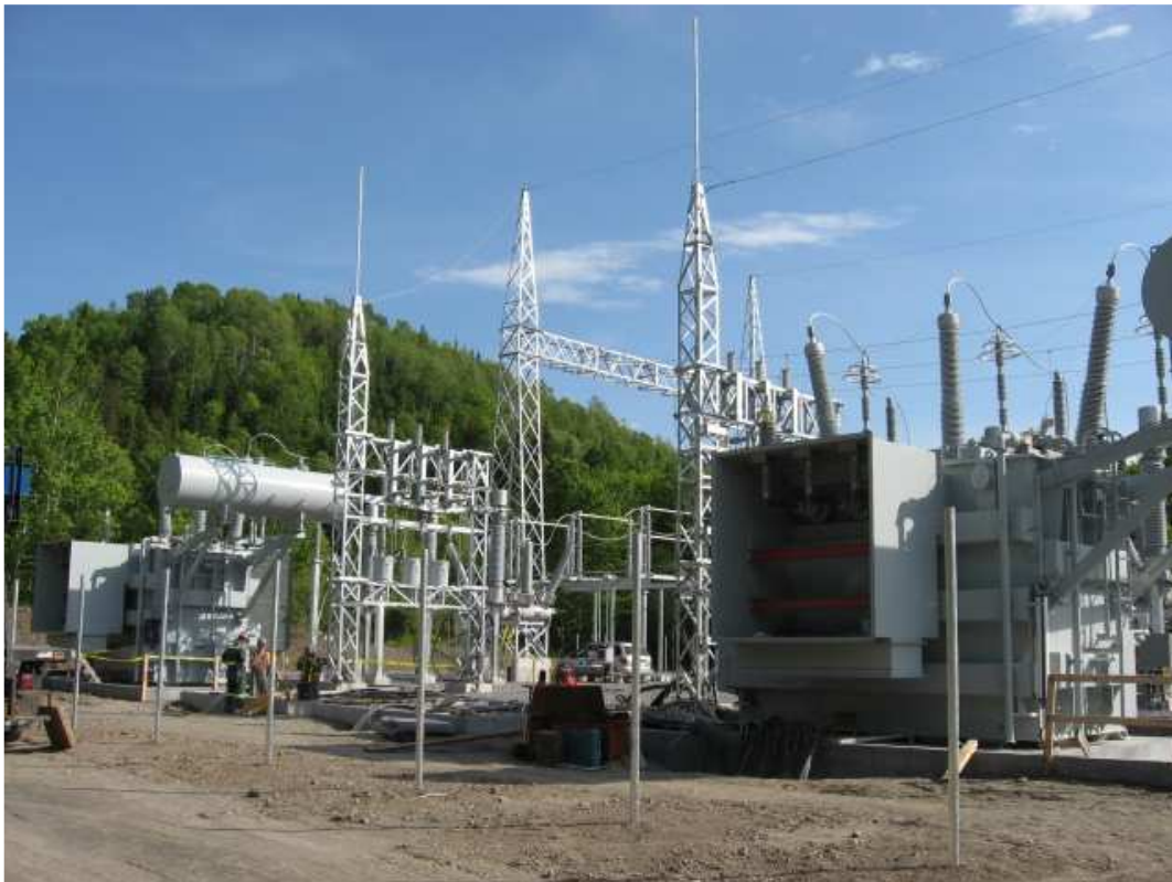
Figure 3.15 Poste élévateur
