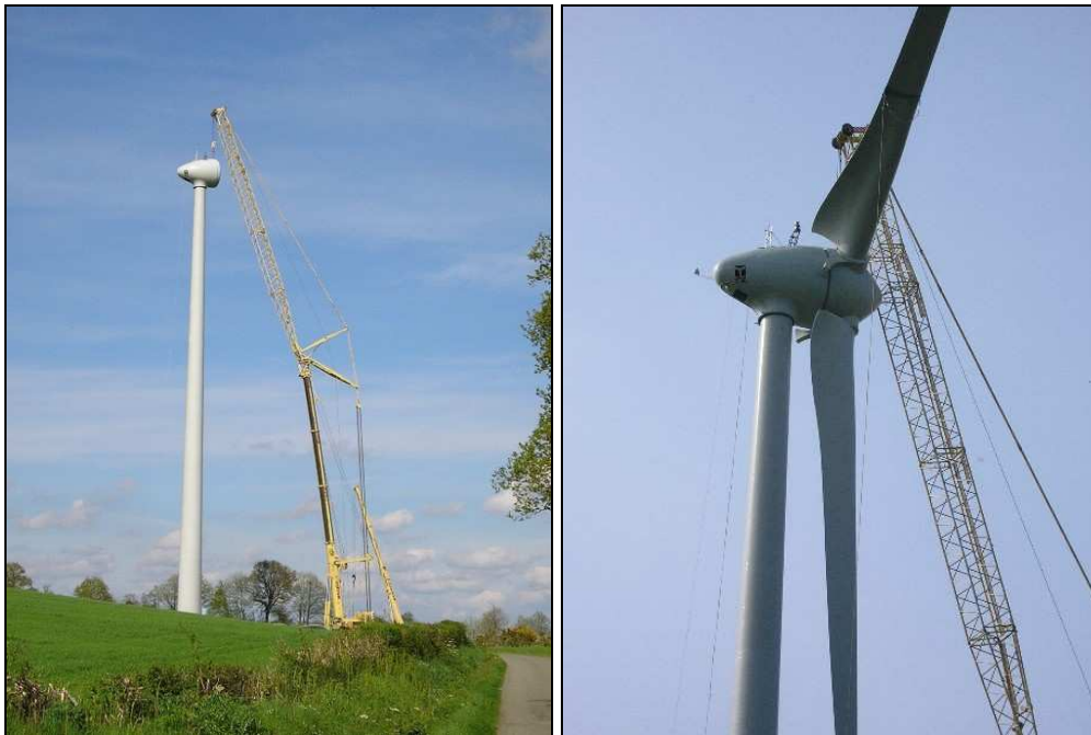
Figure 3.7 Installation de la nacelle et des pales
