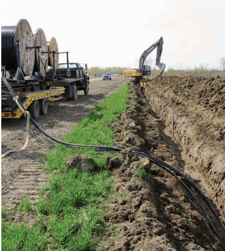
Figure 3.7 Installation des lignes électriques souterraines
