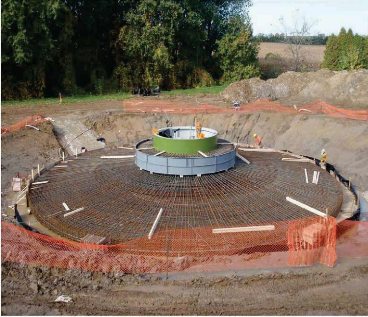
Figure 3.3 Fondation d'éolienne en construction
