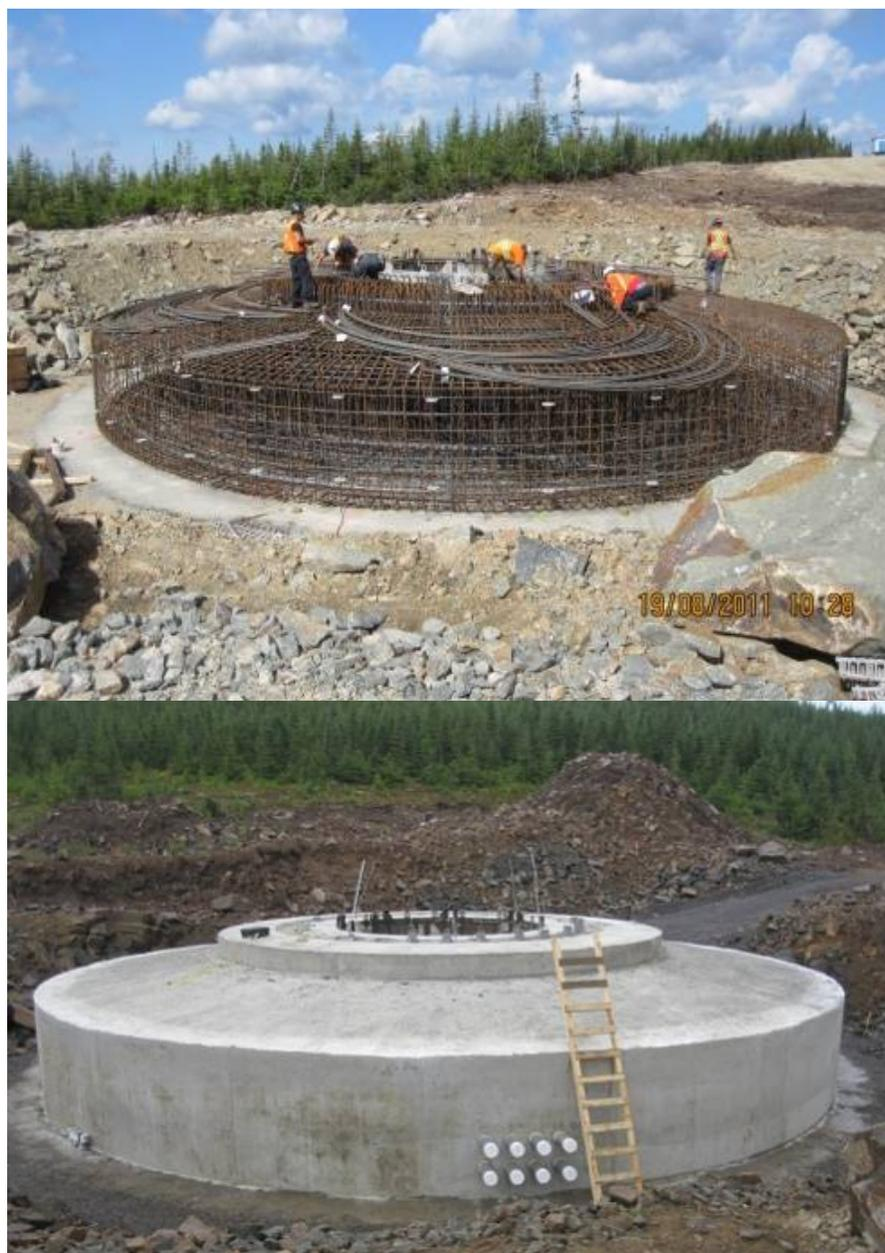
**Figure 3.6** Fondation type d'une éolienne Enercon
