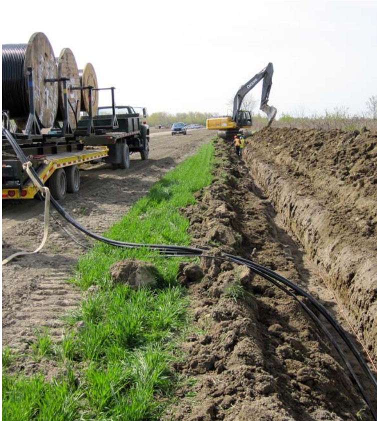
Figure 3.9 Installation des lignes électriques souterraines
