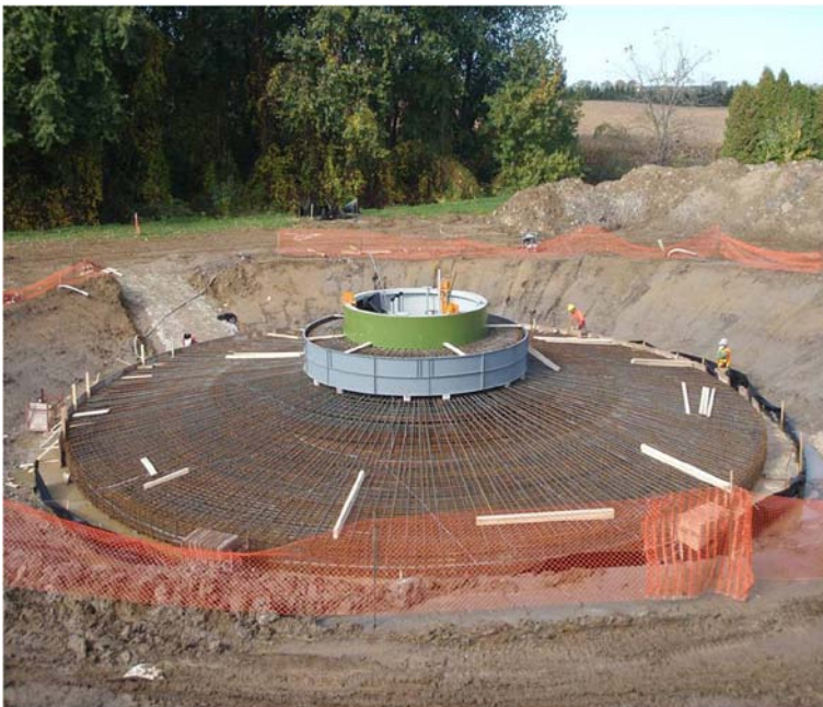
Figure 3.5 Fondation d'éolienne en construction
