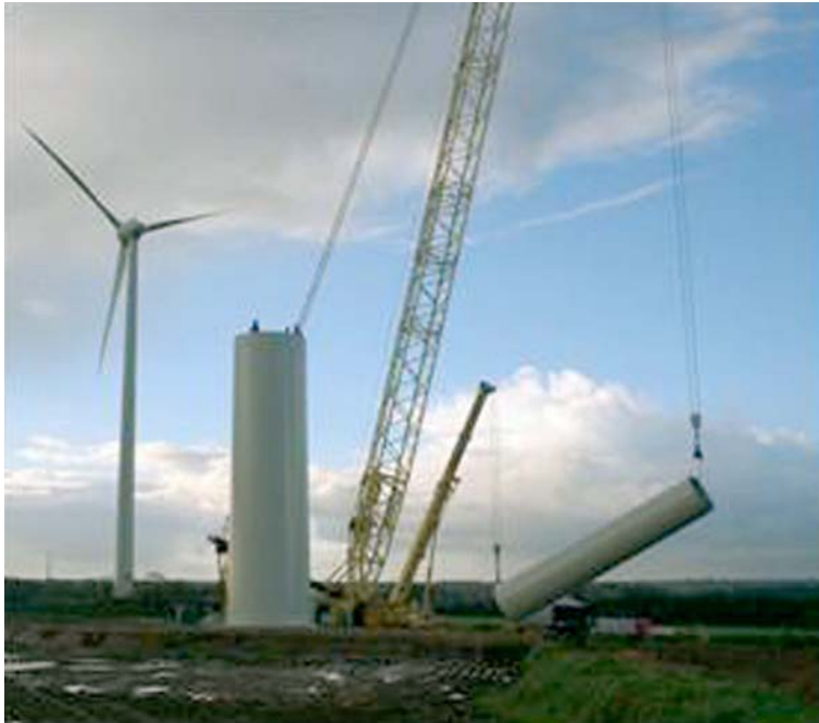
Figure 3.7 Assemblage d'une éolienne
