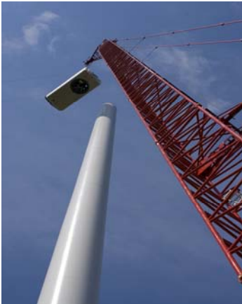
Placement d'une nacelle sur sa tour
