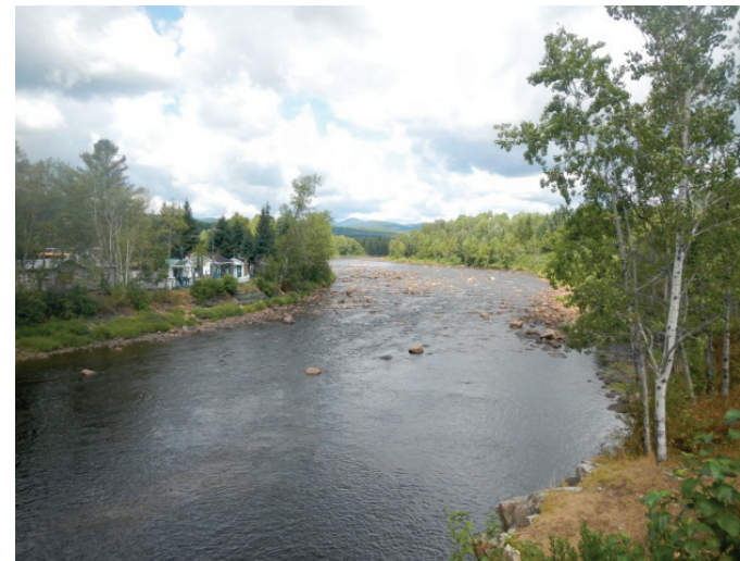
Photo 4 Amont du pont de la rivière Sainte-Anne
