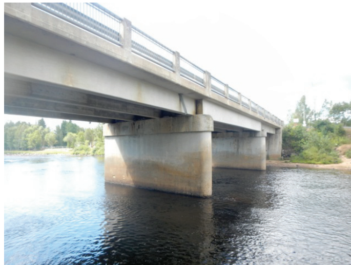
Photo 3 Pont de la Rivière-Sainte-Anne
