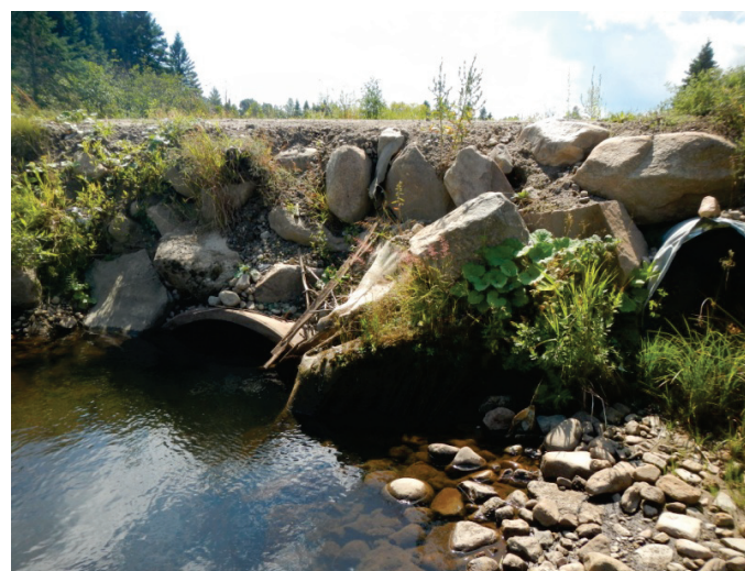
Photo 8 Traverse de cours d'eau sur le tracé B
