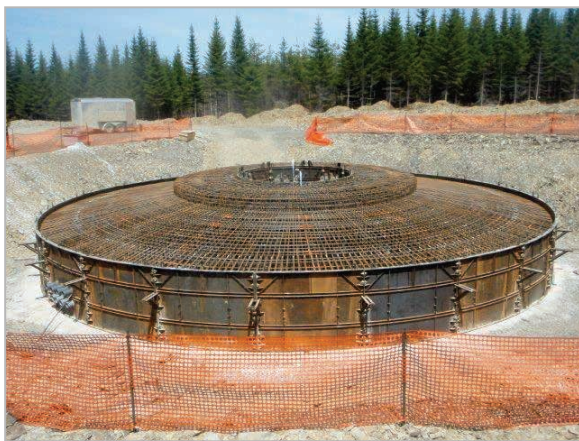
Figure 3.3 Fondation d'éolienne en construction
