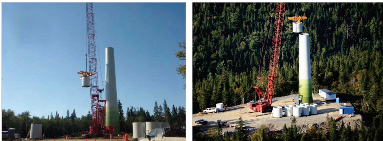
Figure 3.4 Assemblage d'une éolienne
