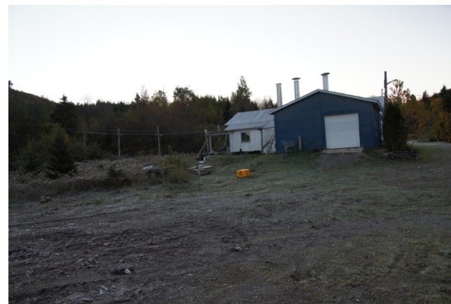
Photo 2. Vue du côté est
