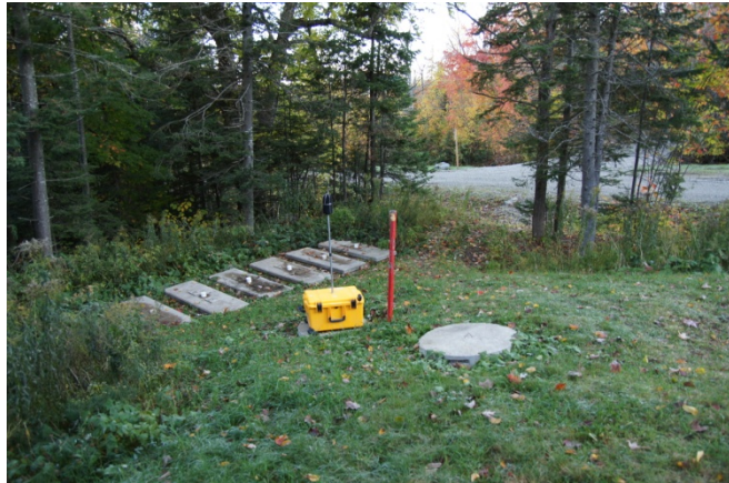
Photo 1. Vue du côté nord
