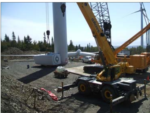
◀ Mise en place de la nacelle - Poids de la nacelle : 65 tonnes
