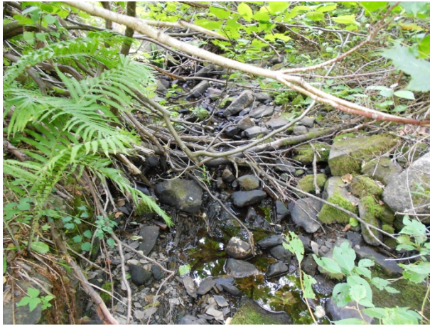
Photo 7. Éolienne 7 (trav. #1) – Tronçon traverse
