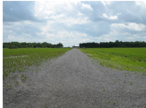
Seuil nord, vue vers le sud le long de l'axe de la piste
