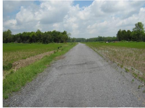
Seuil sud, vue vers le nord le long de l'axe de la piste
