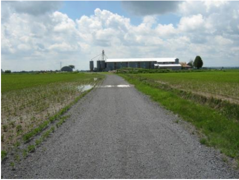
Seuil sud, vue vers le sud le long de l'approche
