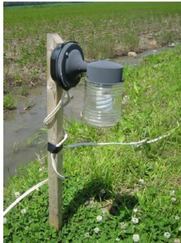
Exemple typique de repère lumineux au Nord de la piste à mi-parcours
