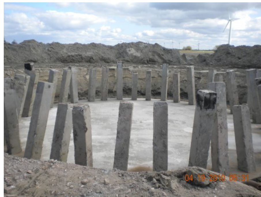
Pieux en béton
