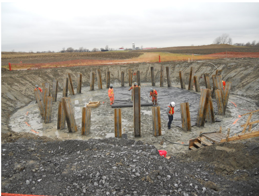
Pieux en métal
