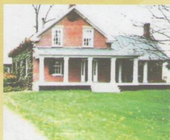
47 - Résidence Hogson-Van Vliet 380, route 221 Nord, Lacolle Construite en 1821. La plus ancienne maison de l'ensemble est inspirée du style néo-classique et agrémentée
