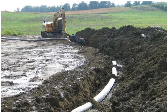
Excavation et pose du drain
