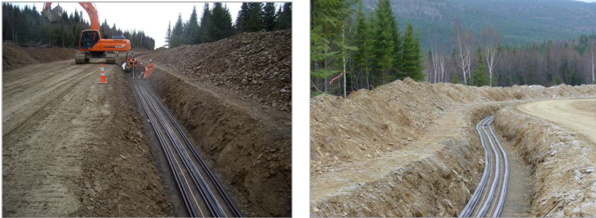
Figure 3.6 Installation de lignes électriques souterraines
