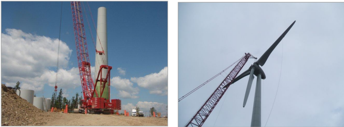
Figure 3.4 Assemblage d'une éolienne
