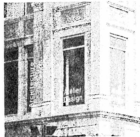
L'affichage doit être confiné à des surfaces n'interférant pas avec les composantes majeures de l'architecture.
