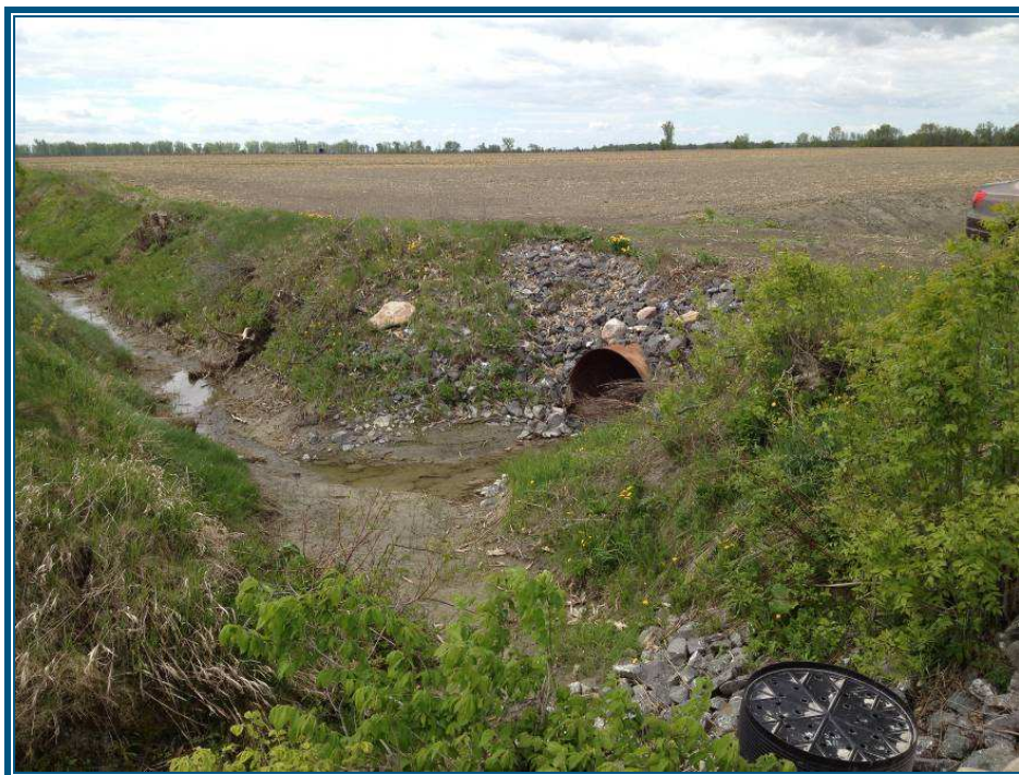
Photo 3 : L'amont du ponceau de la station PS-05.
