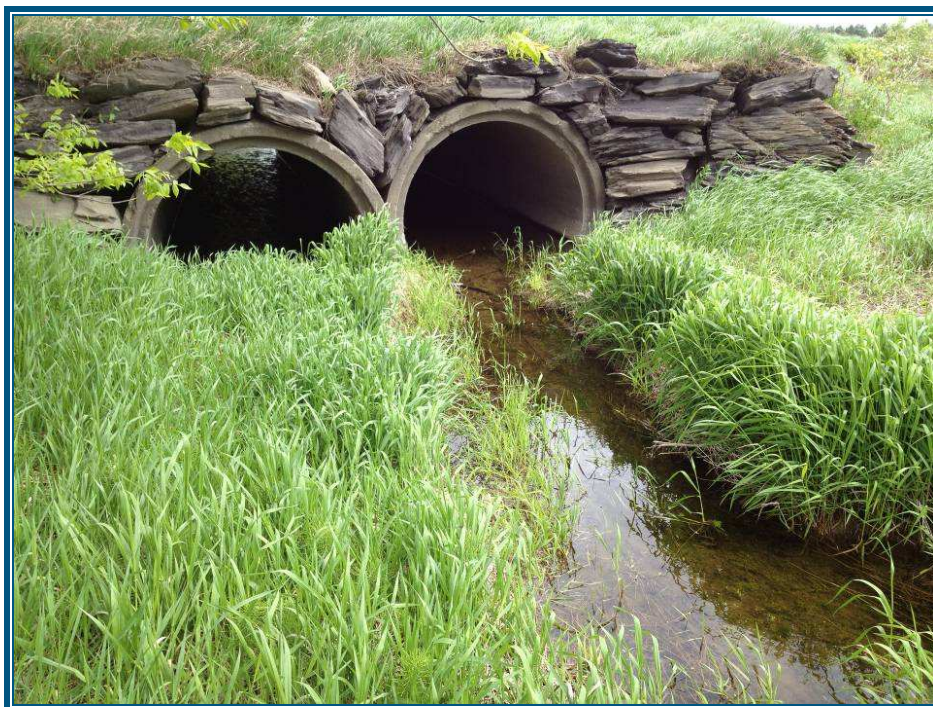
Photo 7 : L'amont du ponceau de la station PS-11.
