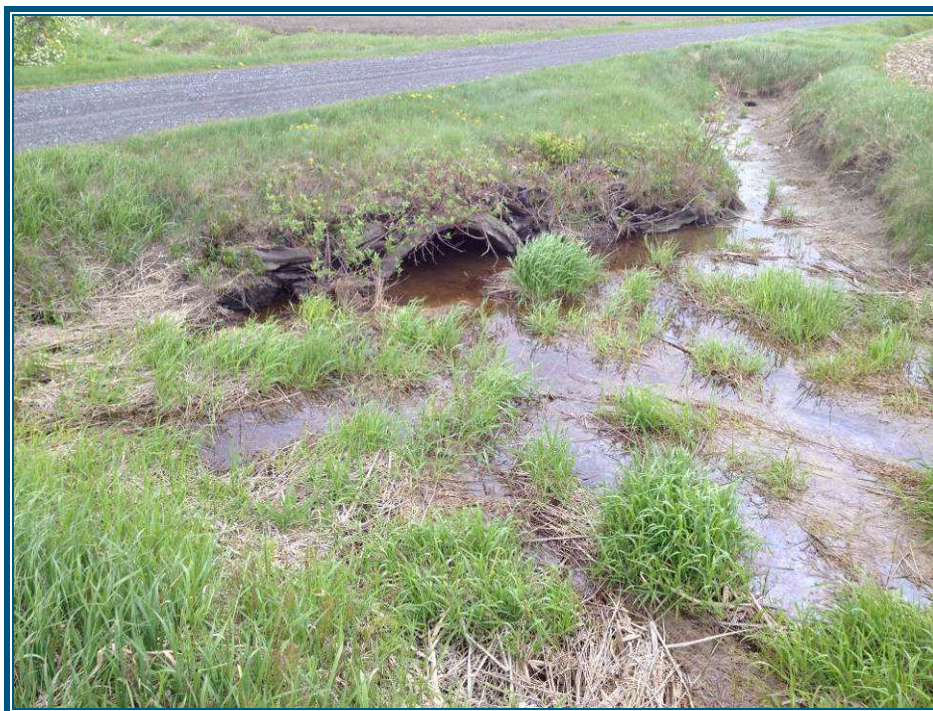
Photo 9 : L'amont du ponceau de la station PS-12.
