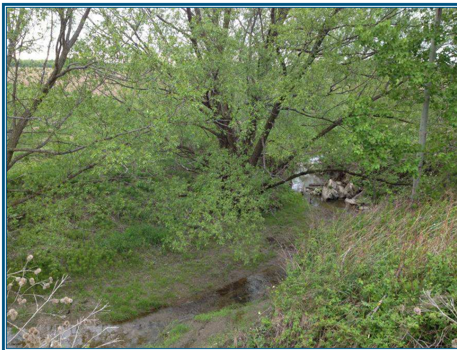
Photo 1 : L'امت du ponceau de la station PS-02.
