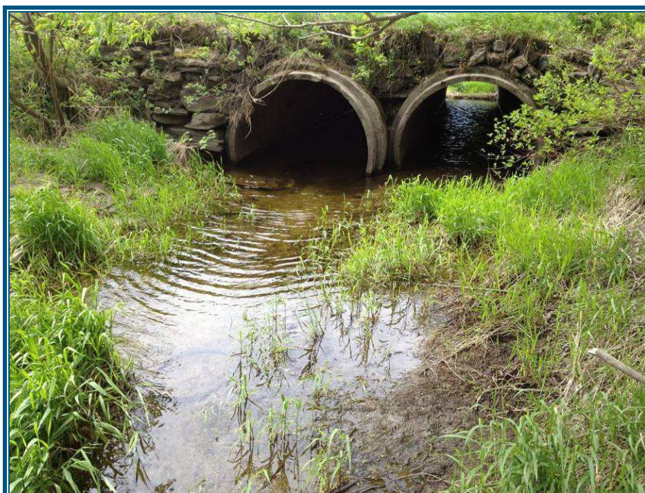
Photo 8 : L'aval du ponceau de la station PS-11.
