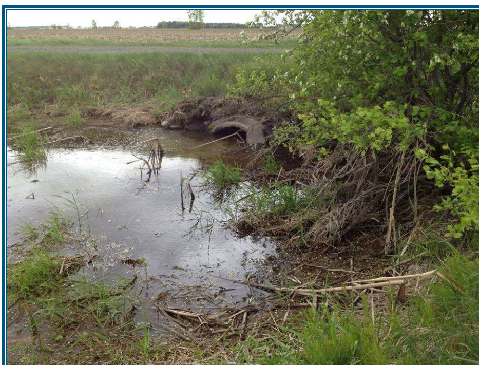
Photo 10 : L'aval du ponceau de la station PS-12.
