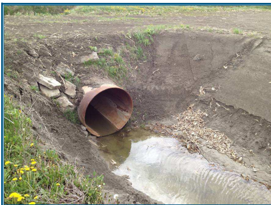
Photo 4 : L'aval du ponceau de la station PS-05.
