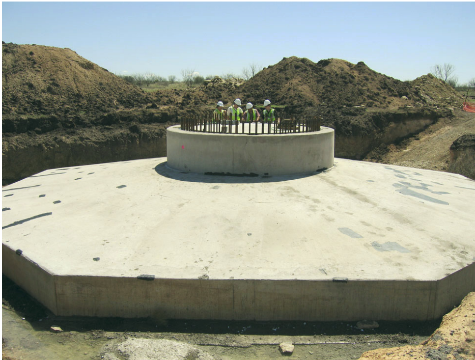
Figure 3.5 Fondation de masse (ou superficielle)
