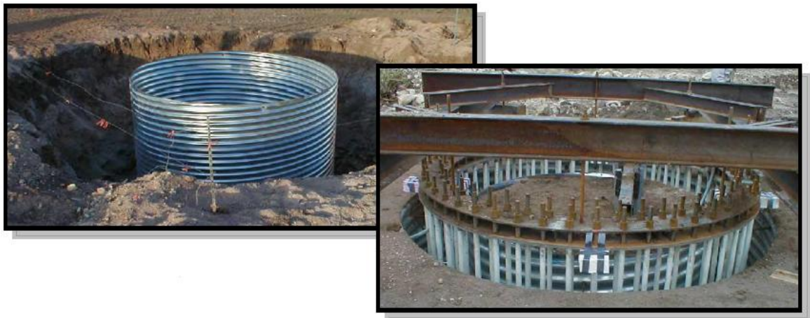
Figure 3.6 Fondation profonde annulaire
