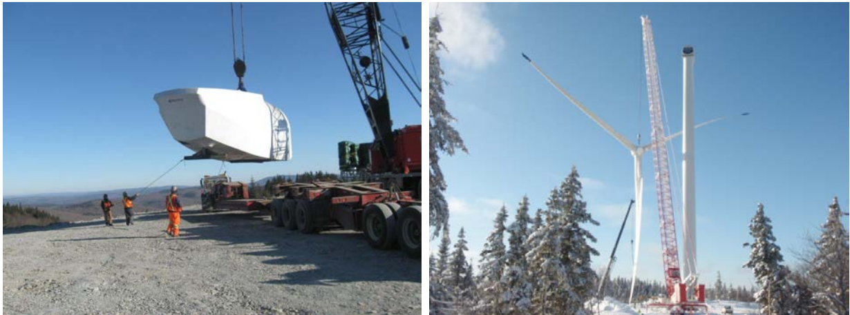
Figure 3.9 Levage d'une nacelle et d'un rotor lors de l'assemblage d'une éolienne
