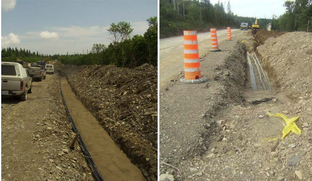
Figure 3.10 Installation du réseau collecteur dans l'emprise d'un chemin
