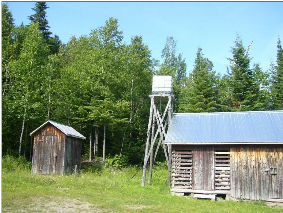
Figure 5.16 Deux remises associées à un chalet, au lac Long. Celle de gauche abrite la pompe à essence utilisée pour remplir un réservoir de plastique, afin d'alimenter le chalet en eau, par simple gravité. Source : MRC des Basques
