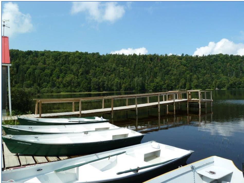
Figure 5.18 Quai pour l'amarrage des embarcations, Grand lac Neigette.
