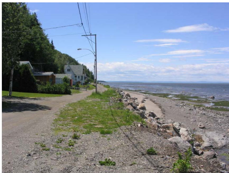
Figure 7. Enrochement du rivage pour contrer l'érosion, grève Morency, Notre-Dame-des-Neiges. Les habitations sont au pied de l'abrupt séparant « Le-Littoral » des « Terrasses ». (C2906_0015)
