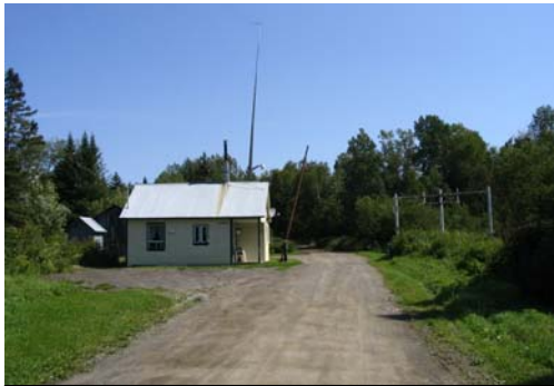
Poste d'accueil Club Appalaches
