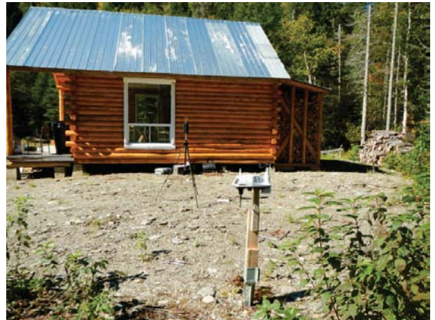
Photo 4. Vue dans la direction ouest
