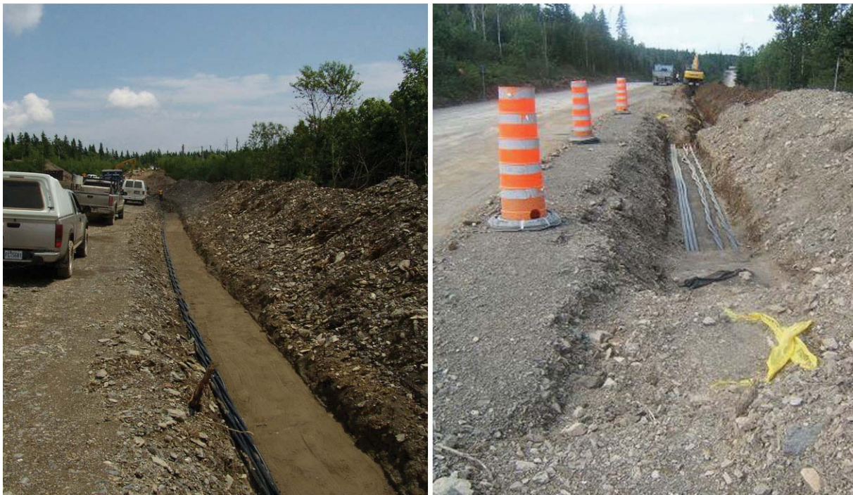
Figure 3.6 Installation de lignes électriques souterraines
