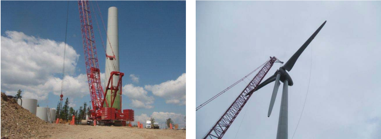
Figure 3.5 Assemblage d'une éolienne
