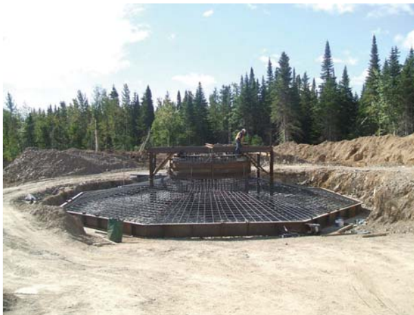
Figure 3.4 Fondation d'éolienne en construction
