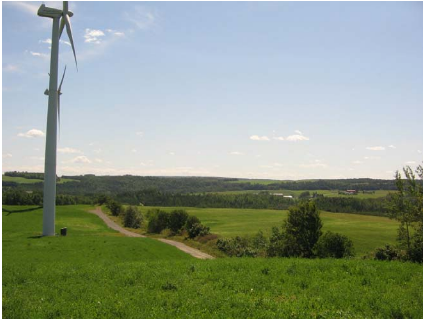
Figure 3.1 Chemin d'accès types, Parc Le Nordais, 2005
